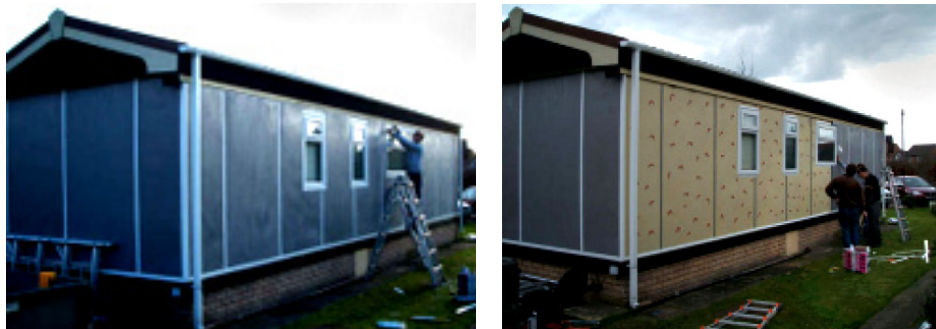
Fig.6.57. Reabilitare clădire cu saltele flexibile gri de aerogel
