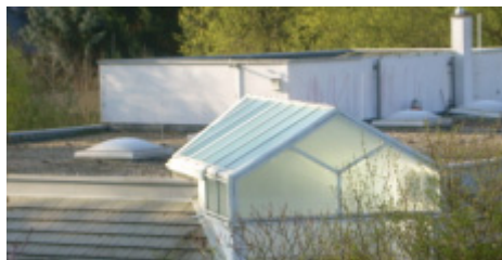
Fig.6.53. Acoperiș vitrat după reabilitare
