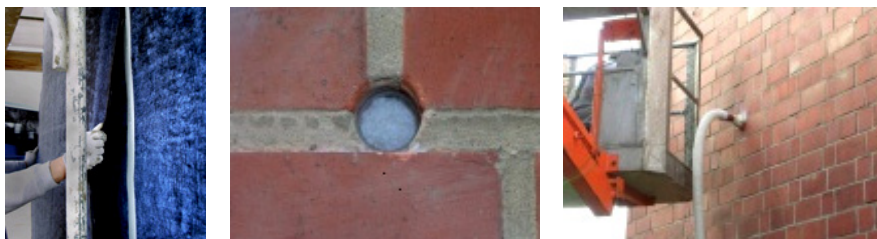
Fig. 7.3. Reabilitarea termică a pereților plini cu aerogel
