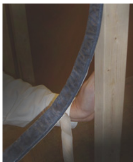
Fig.7.2. Izolarea cu aerogel a elementelor tip bară
