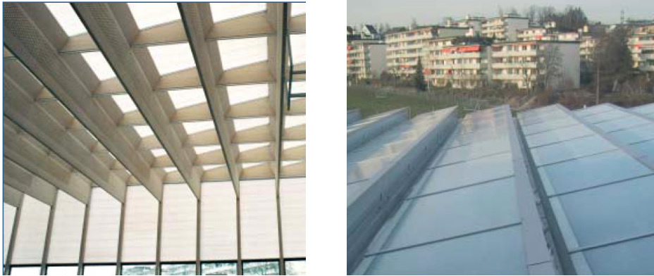
Fig.3.22. Complex sportiv școlar Buchwiesen Hall, Zürich (Elveția)
