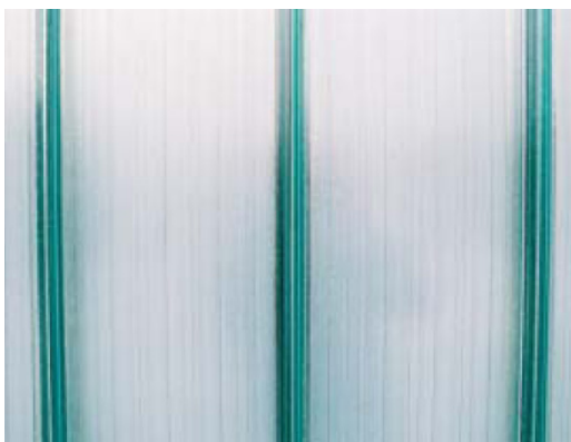
Fig.3.67. Panou din sticlă profil U cu panou din policarbonat cu aerogel încorporat
