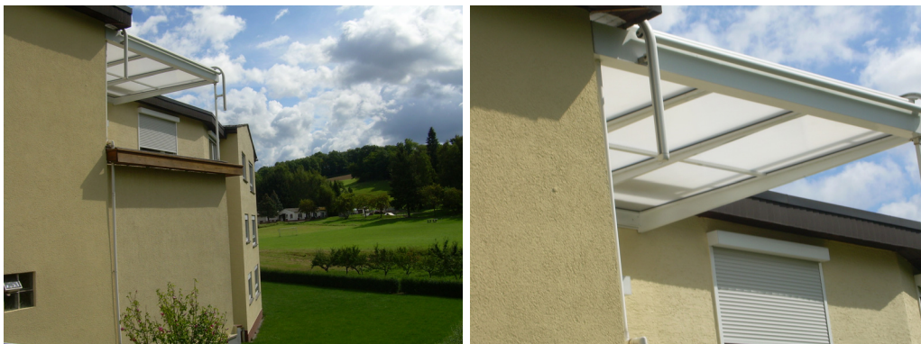
Fig.6.50. Copertină după reabilitare cu panouri din policarbonat cu nanogel translucid încorporat
