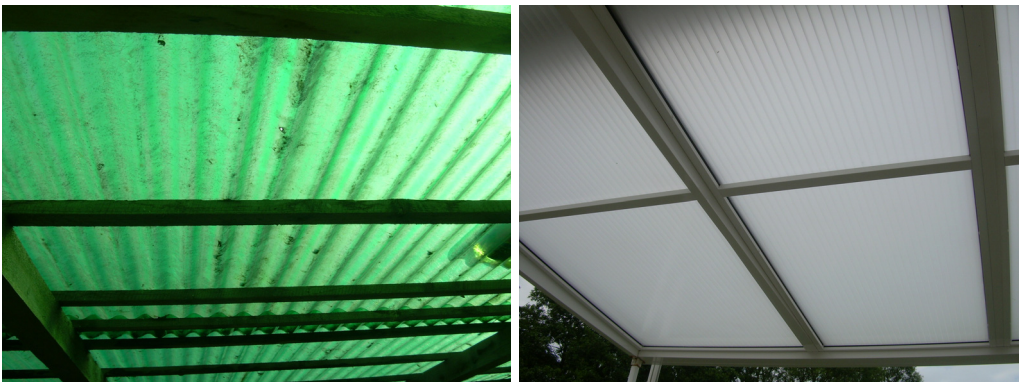
Fig.6.48. Reabilitarea unei copertine pentru terasă la o casă privată
