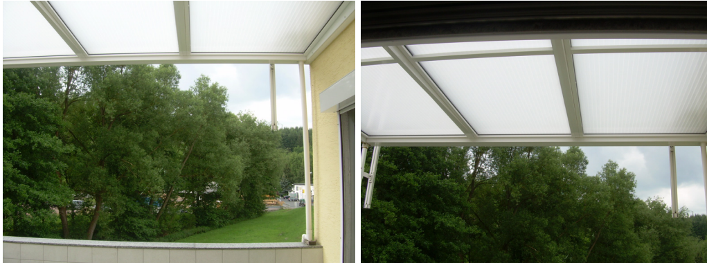
Fig.6.49. Copertină după reabilitare cu panouri din policarbonat cu nanogel translucid încorporat
