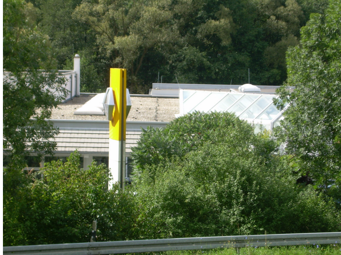
Fig.6.51. Acoperiș vitrat înainte de reabilitare
