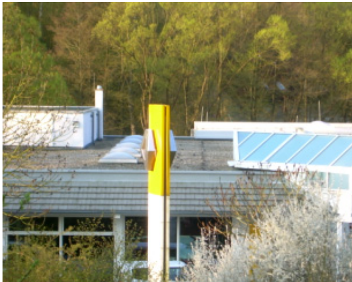
Fig.6.52. Acoperiș vitrat după reabilitare
