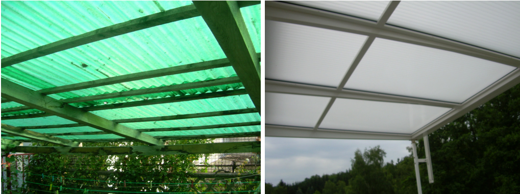
Fig.6.47. Reabilitarea unei copertine pentru terasă la o casă privată
