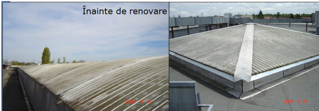
Fig.3.44. Complex comercial Carrefour, Mont de Marsan, Franța
