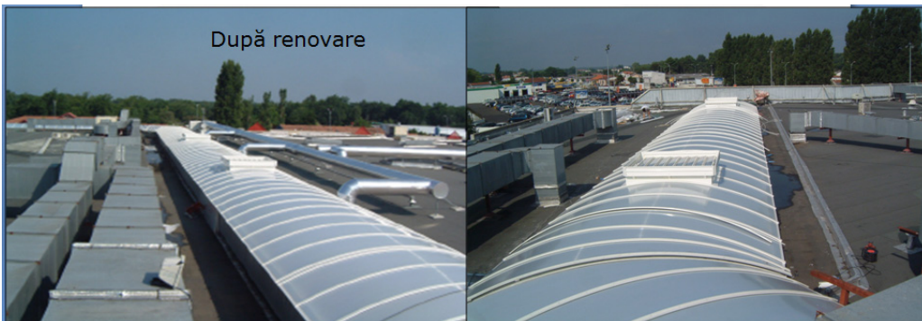
Fig.3.47. Complex comercial Carrefour, Mont de Marsan, Franța
