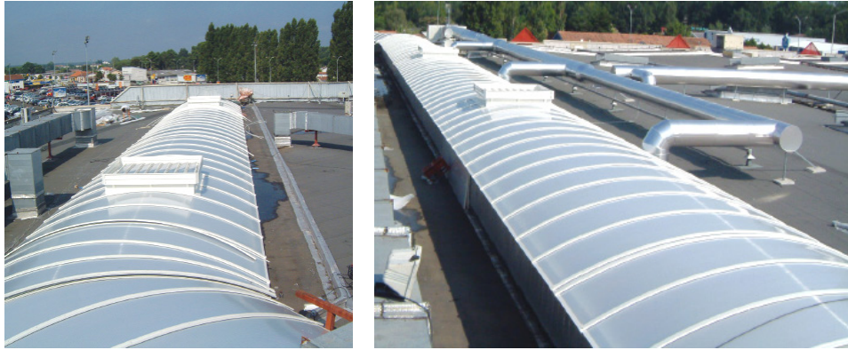
Fig.3.48. Complex comercial Carrefour, Mont de Marsan, Franța
