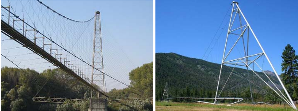
Fig. 1.18. Piloni cu structură zăbreliță
