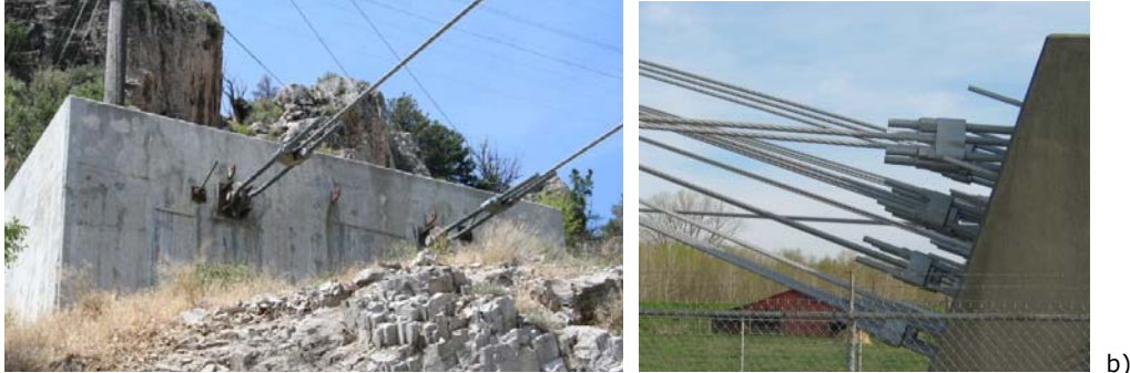
Fig. 1.21. Ancorarea traversărilor
