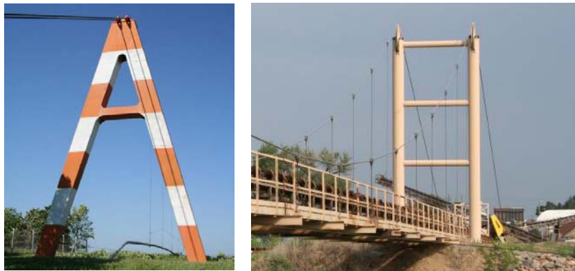
Fig. 1.19. Pilon cu structură în cadre
