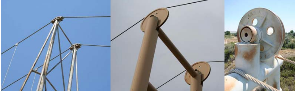
Fig. 1.20. Prinderea pilonilor la partea superioară
