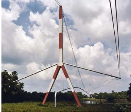
Fig. 1.11. Traversare suspendată cu piloni în formă de stea
