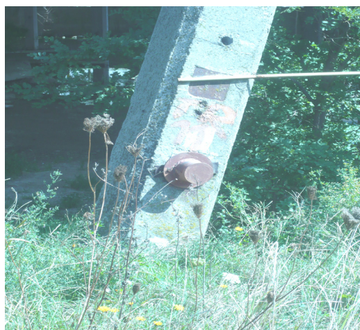
Fig. 5.16. Reper aflat la baza turnurile de răcire - CET Sud Timișoara
