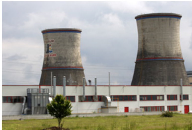
Fig. 5.14. Turnurile de răcire - CET Sud Timișoara
