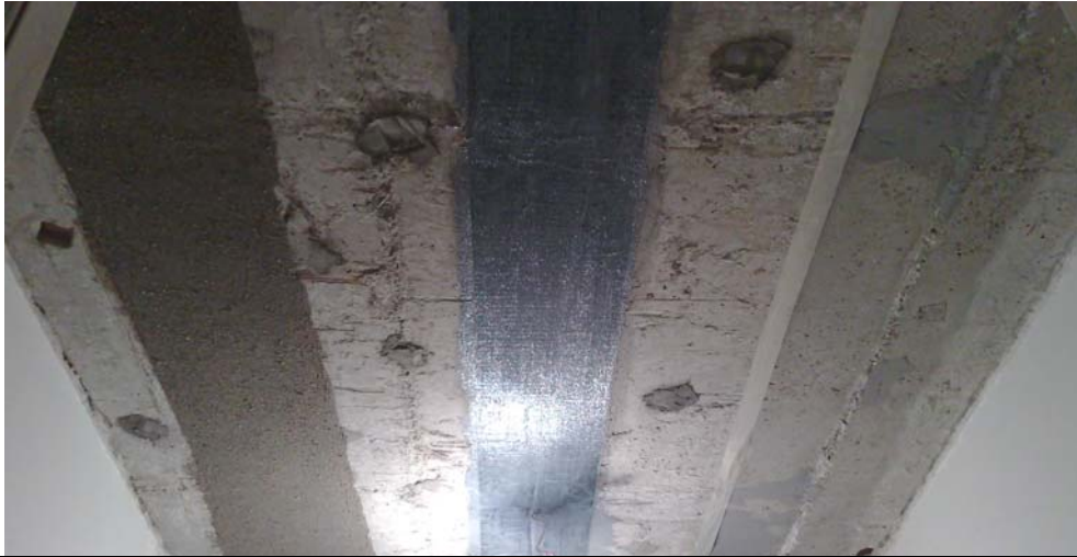
Fig. 8.4. - Vedere a plăcii într-o etapă intermediară a procesului de consolidare
