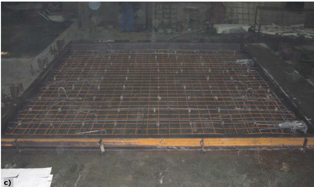
Fig. 6.9. - Caracteristici geometrice și armare inferioară și superioară elemente RCS-RLC-01 și RCS-RLC-02
