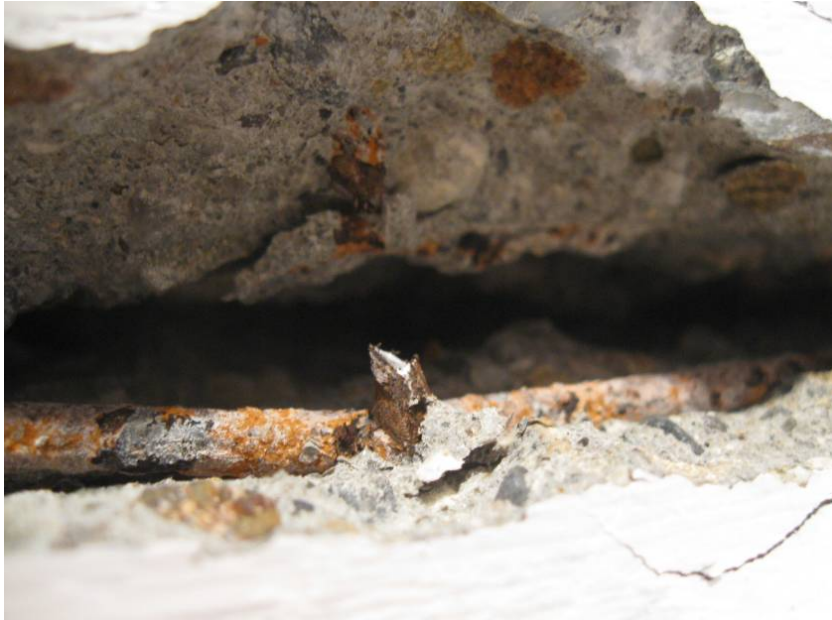
Fig. 6.58. - Ruperea unei bare de armătură într-o zonă de nod a plasei inferioare
