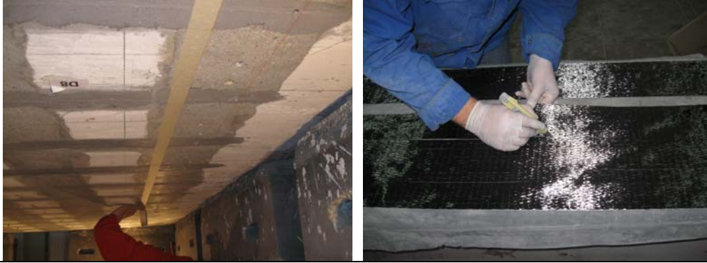
Fig. 6.27. - Marcarea poziției fâșiilor de CFRP și pregătirea acestora pentru aplicare
