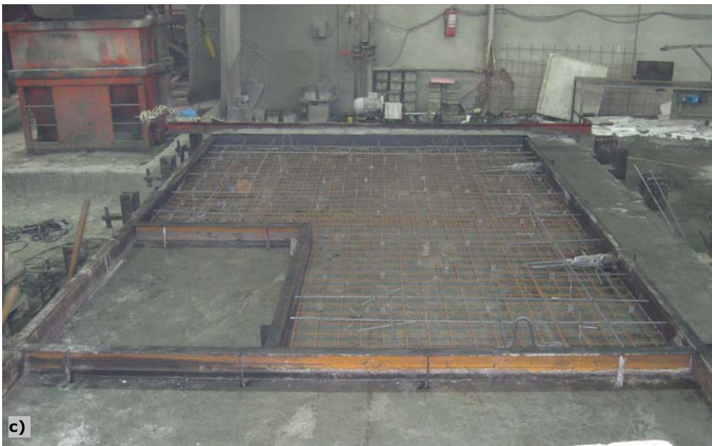
Fig. 6.8. - Caracteristici geometrice și armare inferioară și superioară element RCS-RSC-01
