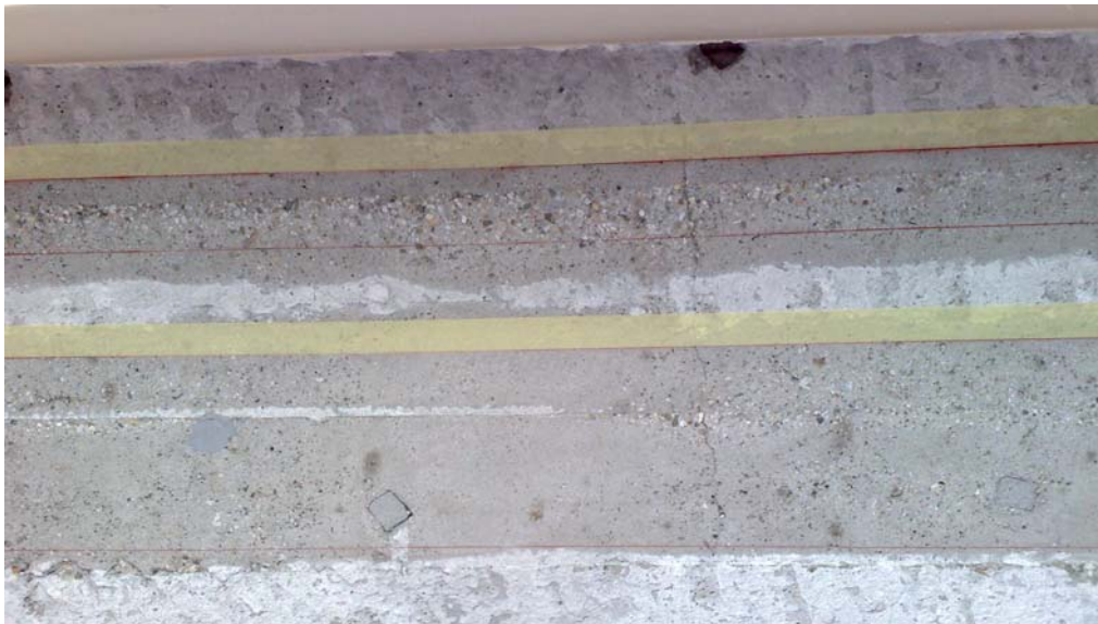
Fig. 8.3. - Vedere a plăcii într-o etapă intermediară a procesului de consolidare
