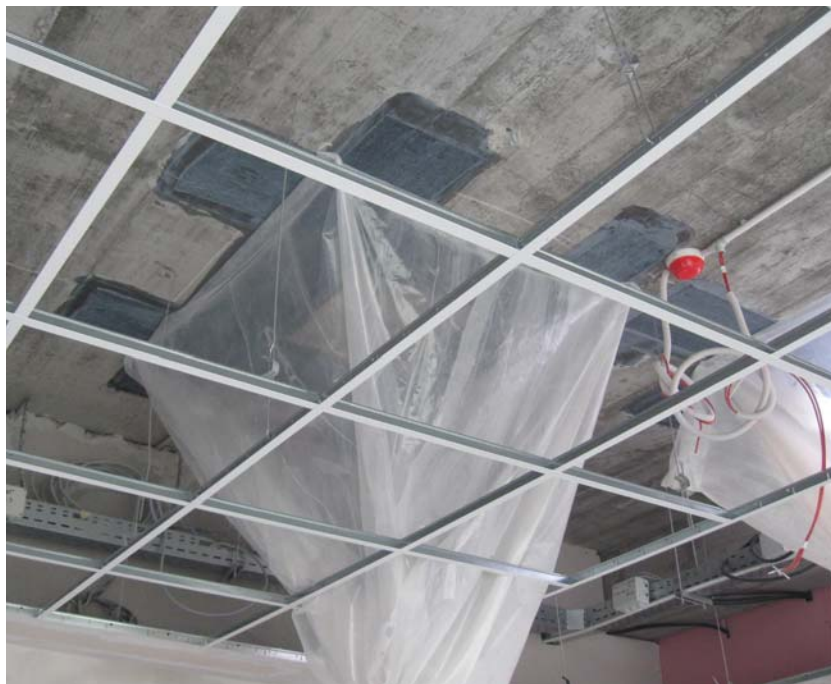
Fig. 8.9. - Vedere a unei zone consolidate, înainte de tăierea golului
