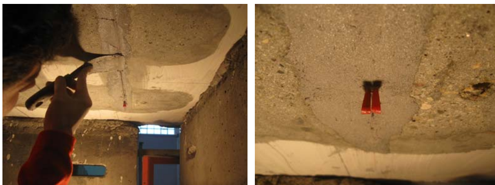
Fig. 6.26. - Finisarea suprafeței în zona șlițurilor
