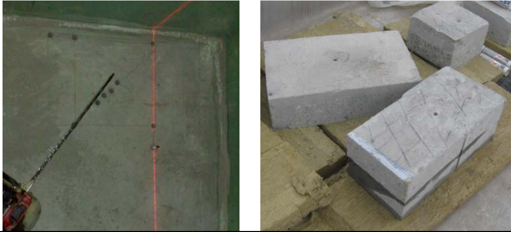
Fig. 8.8. - Marcarea și ghidarea tăierii; bucăți de placă eliminate prin tăierea golului
