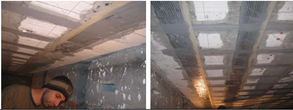
Fig. 6.28. - Întinderea și pregătirea primului strat de rășină
