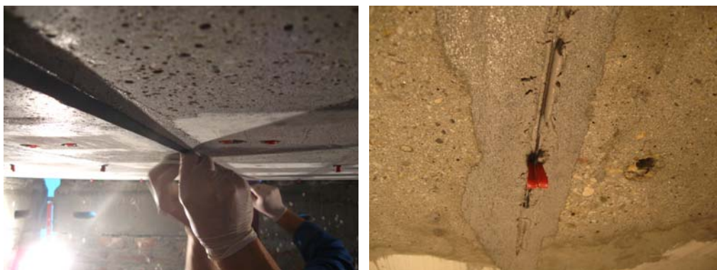
Fig. 6.25. - Inserarea benzilor de CFRP direcționate cu ajutorul penelor
