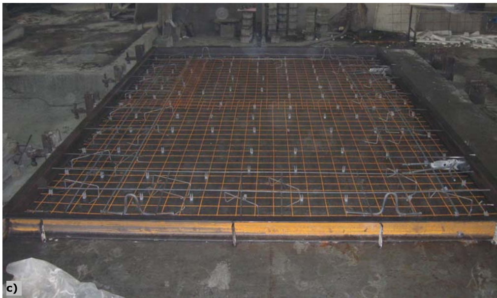
Fig. 6.7. - Caracteristici geometrice și armare inferioară și superioară element RCS-FS-01
