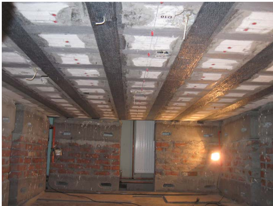
Fig. 6.30. - Vedere a feței inferioare a plăcii după finalizarea consolidării
