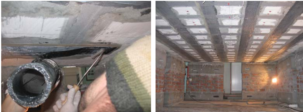
Fig. 6.29. - Aplicarea fâșiilor de țesătură și o vedere a feței inferioare în timpul procesului de consolidare (cele trei fâșii din dreapta sunt aplicate iar în stânga este aplicată doar rășina)
