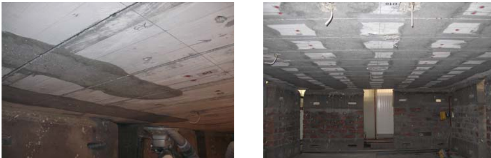
Fig. 6.20. - Șlefuirea suprafețelor pentru aplicarea fâșiiilor de țesătură
