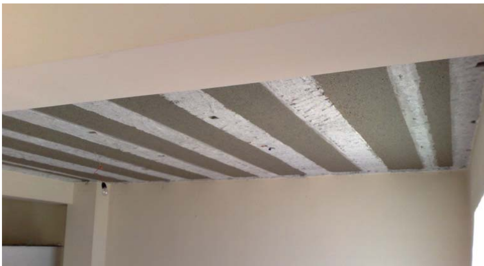
Fig. 8.5. - Suprafața inferioară a plăcii la finalul procesului de consolidare
