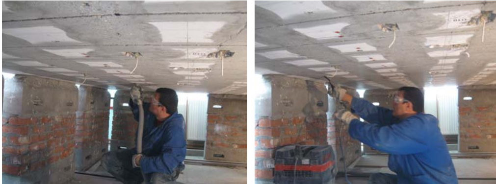
Fig. 6.21. - Curățarea șlițurilor și a suprafețelor șlefuite prin aspirare și suflare cu aer
