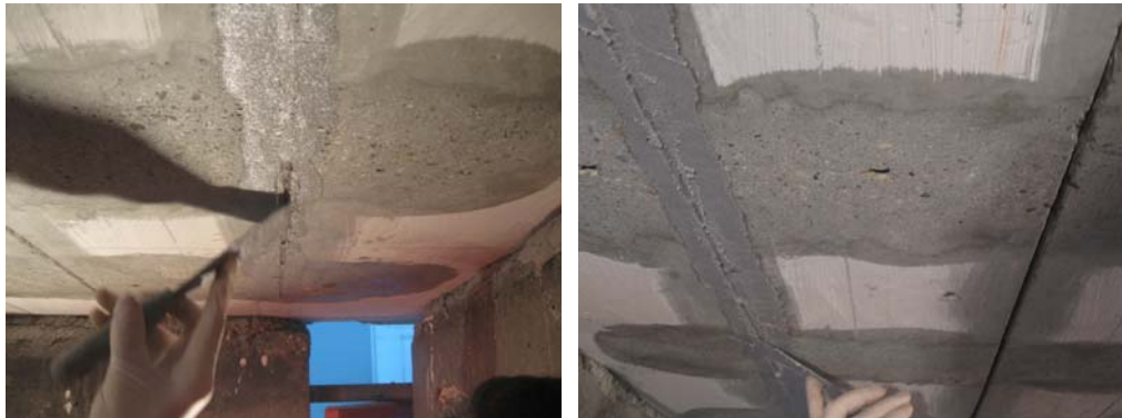
Fig. 6.24. - Corectarea șlițului umplut cu rășină
