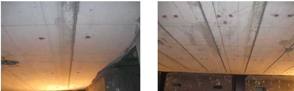
Fig. 6.19. - Tăierea șlițurilor și aspectul feței inferioare după tăiere
