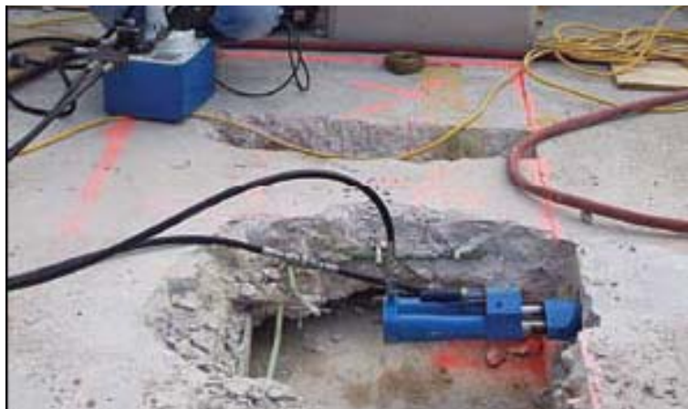
Fig. 2.21. - Secvență din procedeele de consolidare prin post-tensionare a plăcilor de beton armat (cf. [112])
