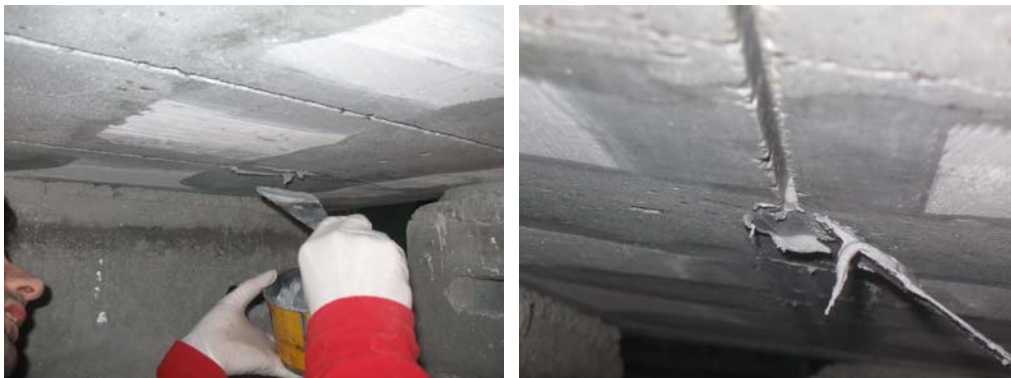
Fig. 6.23. - Umplerea șlițurilor cu rășină epoxidică
