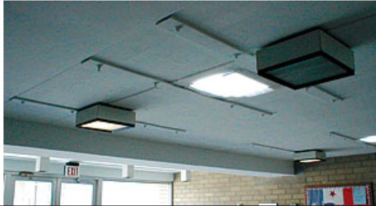
Fig. 2.18. - Instalarea unui ansamblu structural metalic ancorat mecanic (cf. [045])
