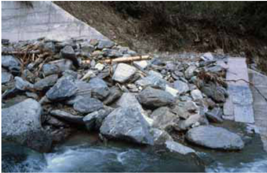
Fig. 2.5. Aluviuni cu pietre și bolovani în sistemul de corectarea torenților
