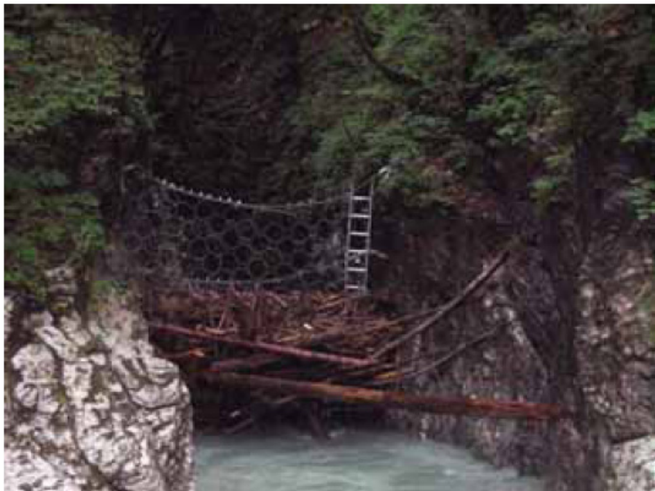
Fig. 2.2. Aluviuni cu material lemnos în canalul torențial
