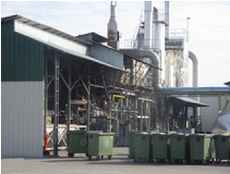
Fig.1.2 Incineratorul de deșeuri speciale aflat în funcțiune la SC PRO AIR CLEAN Timișoara[93]
