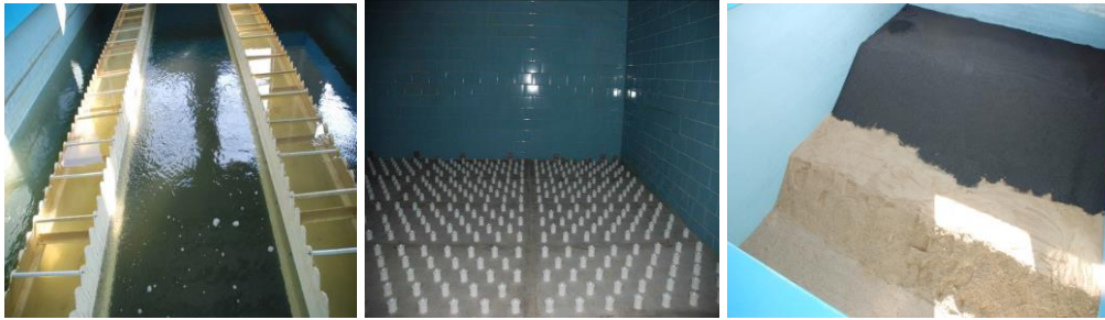
Fig. 6.7 Imagine a filtrelor rapide deschise
