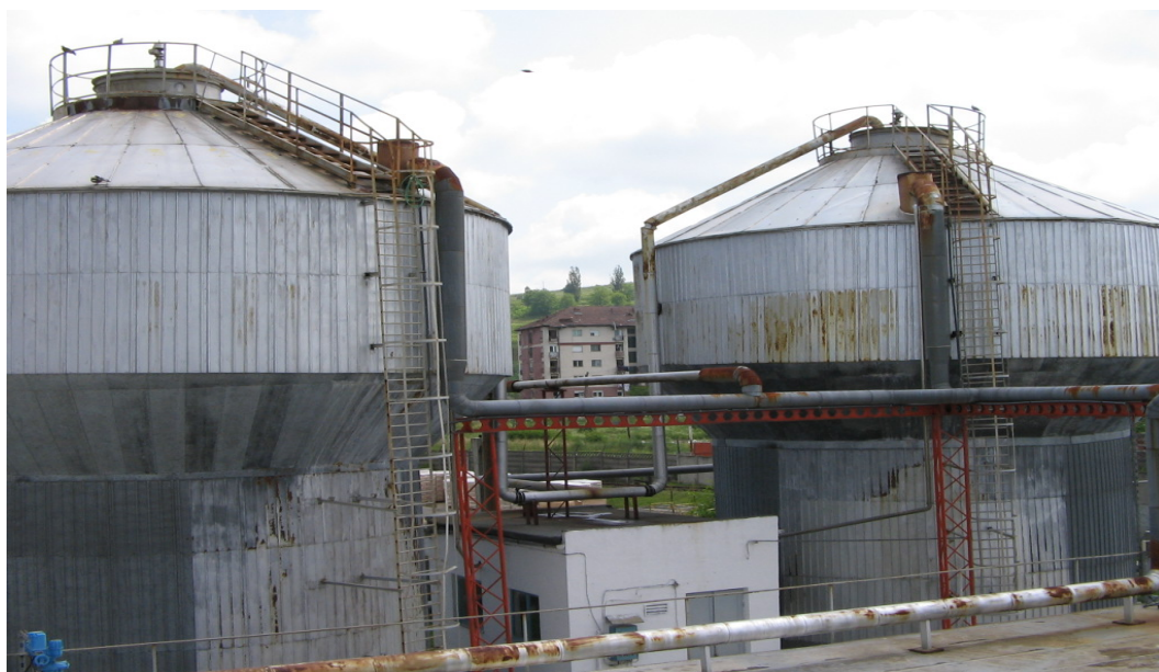
Figura 3.20 Reactoare UASB
