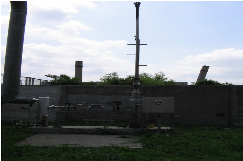
Figura 3.23 Arzător biogaz
