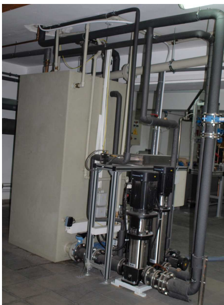
Fig.6.3. Sursa de alimentare cu apă a instalației
