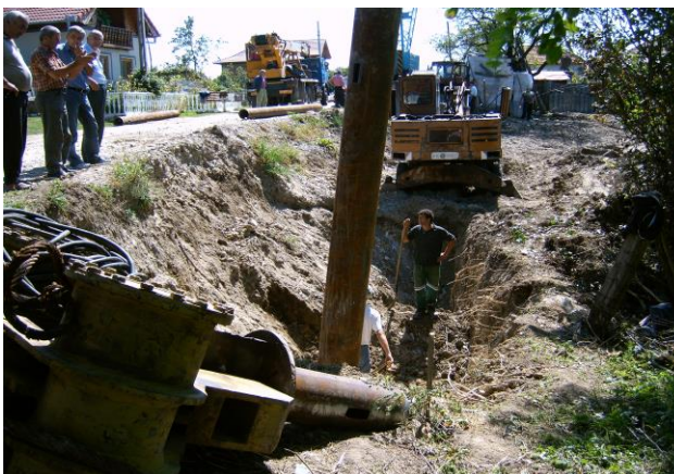
Foto nr.4.7. Introducerea tuburilor metalice în găurile de foraj
