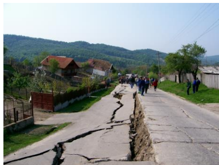
Foto nr.1.11: Com Roșia de Amaradia Foto nr.1.12 : Drum Județean 675 C Pierdere stabilitate versant și terasament drum județean
