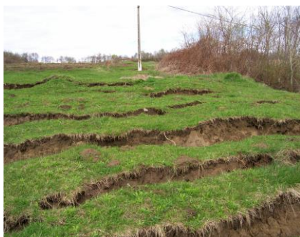
Foto nr.1.11: Com Roșia de Amaradia Foto nr.1.12 : Drum Județean 675 C Pierdere stabilitate versant și terasament drum județean
