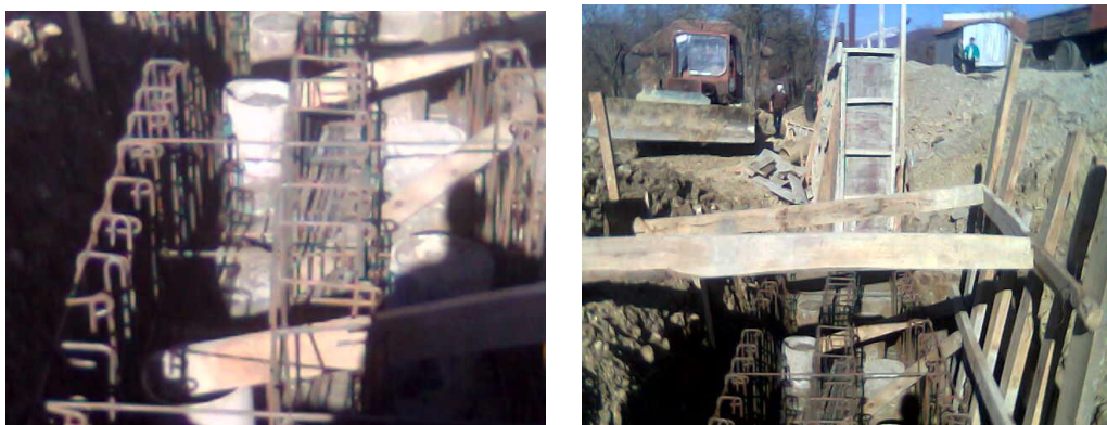
Foto. nr.4.10. Armarea radierului, betonarea radierului și a elevației zidului
