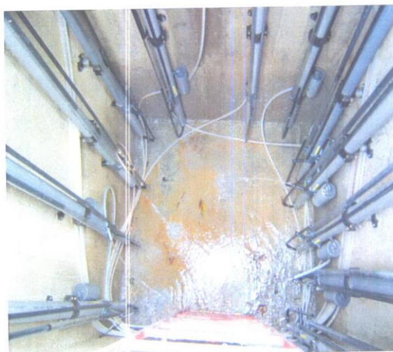
Cămin de vizitare Ø1000-1500 mm cu sasuri automate
