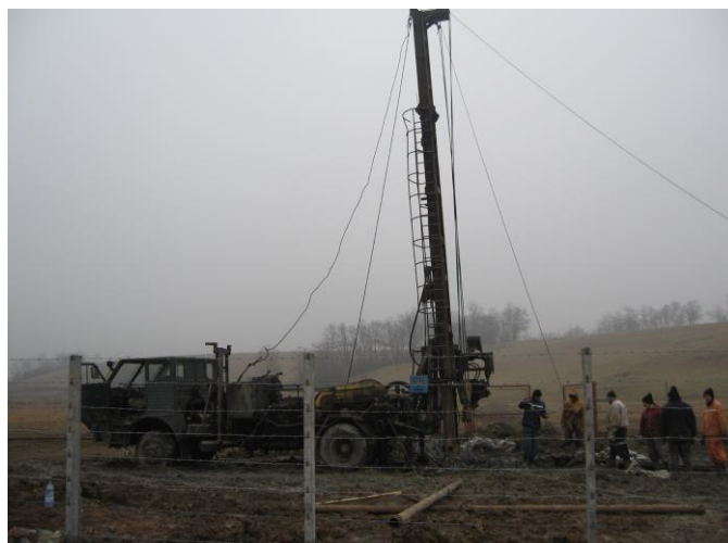
Foto nr.4.5. Forarea găurilor cu instalație de foraj FA - 6,3 C
