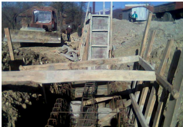
Foto nr.4.11. Betonare radier
