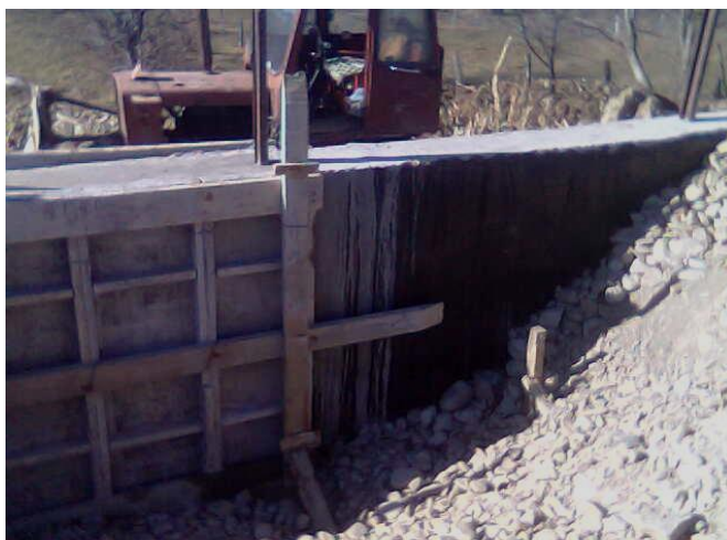
Foto nr. 4.12. Betonare elevație zid de sprijin
