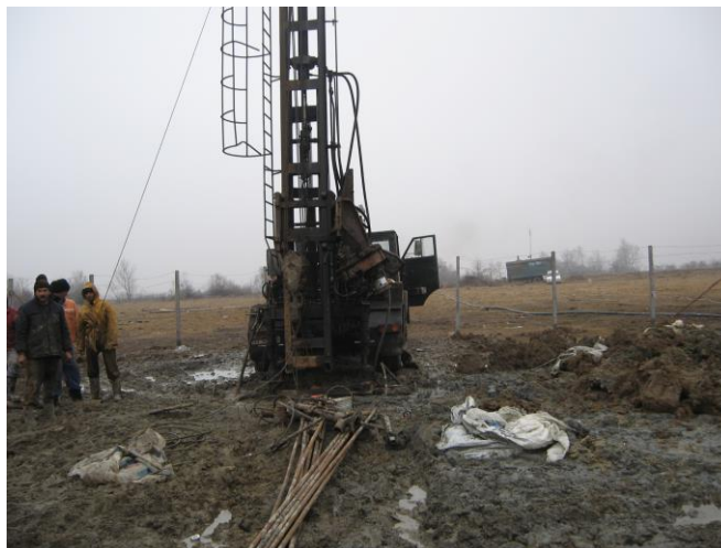
Foto nr.4.4 – Instalația de Foraj FA – 6,3 C
