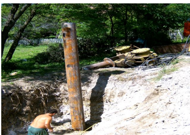
Foto nr.4.8. Injectarea tuburilor cu lapte de ciment
