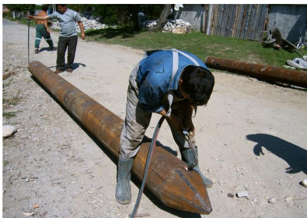
Foto nr.4.6. Pregătirea tuburilor
