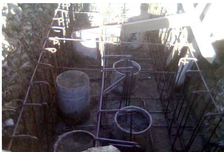
Foto nr. 4.9. Armare și betonare radier
