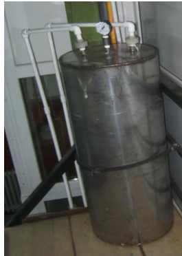
Figura 4.17. – Rezervor stocare biogaz [11]
