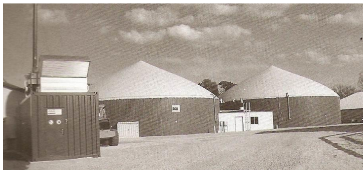
Figura 3.22. - Ferma Vir-Clar, Winsconsin, 2 x 2600 m 3 substrat, 70 m 3 /zi urina de vita, centrala termica de bloc de 330 kW de la SEVA-Caterpillar. (Firma Biogas Nord GmbH) [20]
