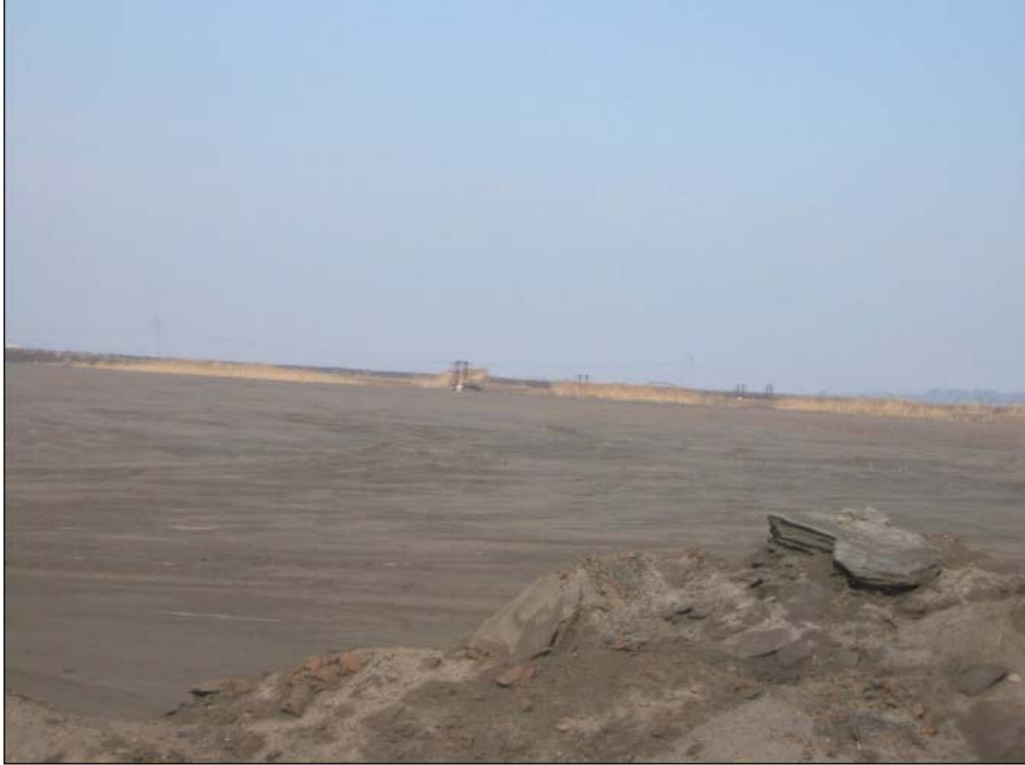
Fig.3 Halda de depozitare a zgurei și cenușei a SC CET Arad SA
