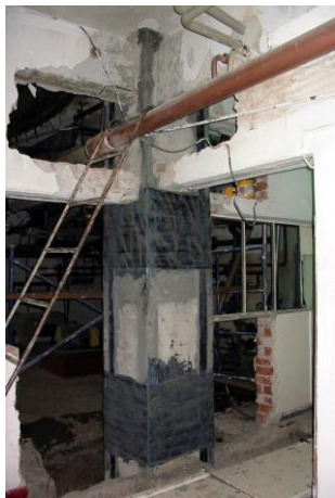
Fig.3.3 a CFRP –reabilitarea la coloană
