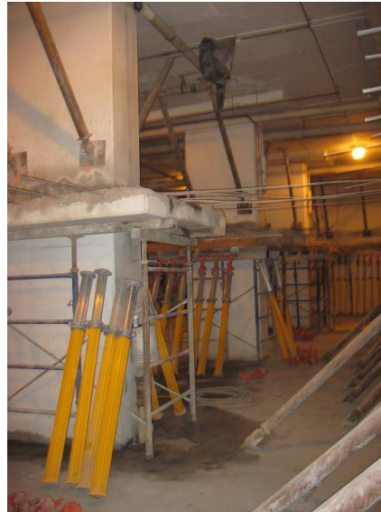
Fig 5.9 Betonarea ariei în jurul stâlpilor(1)
