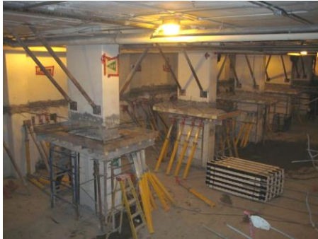
Fig. 5.10 Betonarea ariei în jurul stâlpilor(2)
