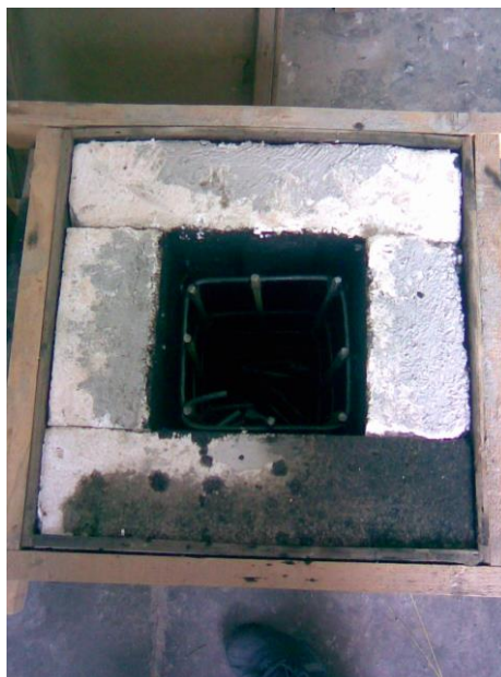
Fig. 6.2 Turnarea stâlpului (elementului de beton interior)
