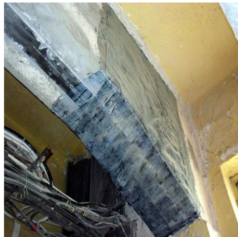
Fig.3.3 b CFRP reabilitarea la grinzi
