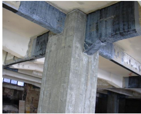
Fig. 3.9 Consolidarea grinziiilor
