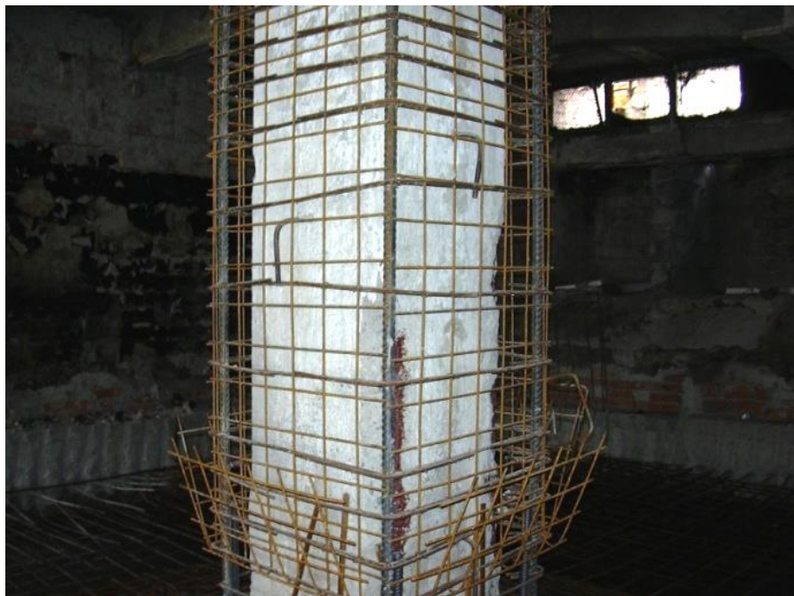
Fig.6.40 Consolidarea coloanei cu ancore chimice
