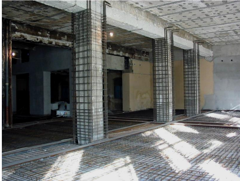
Fig. 3.14 Consolidarea coloanelor și a stâlpilor
