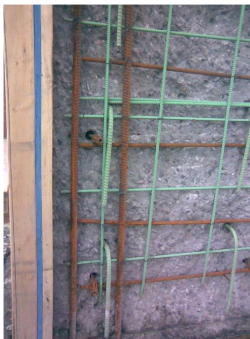
Fig.6.42 Consolidarea cu ancore chimice
