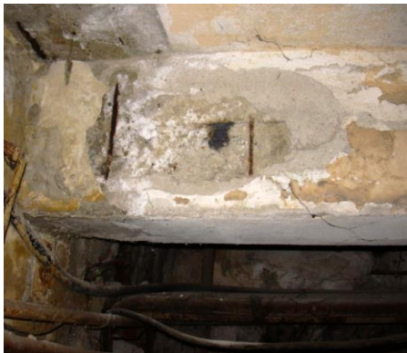
Fig. 3.8 Degradarea grinzilor
