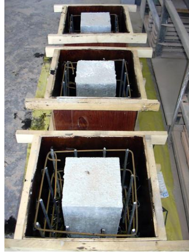
Fig.6.8. Instalarea armăturilor în interiorul cofrajului
