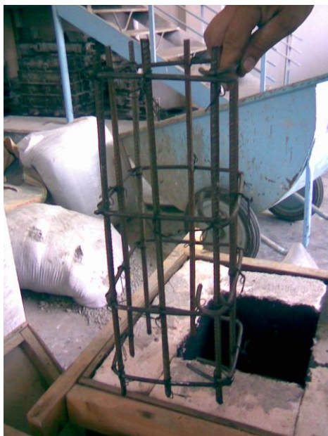
Fig. 6.1 Armarea stâlpului
