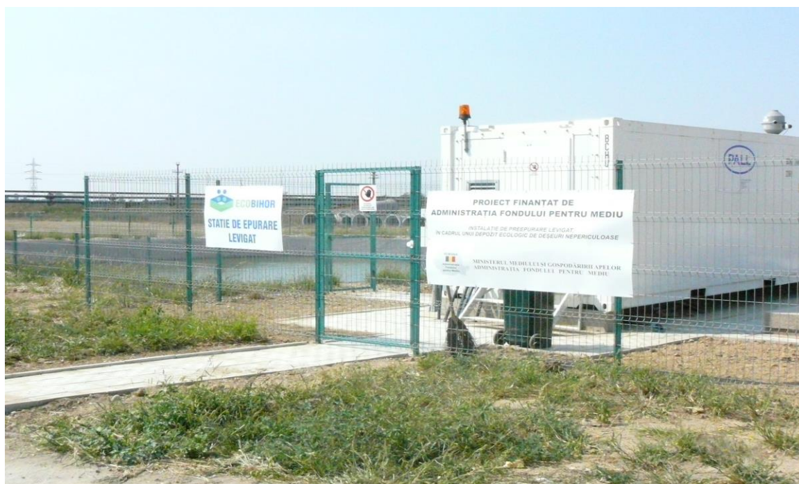
Figura nr. 5.9.6.-5. Suprafață betonată în jurul stației de epurare tip container
