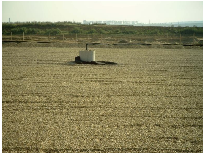
Figura. nr. 3.4.7.4.-1. Puț de captare biogaz realizat
