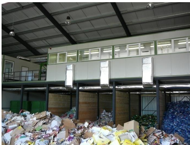
Figura nr. 3.4.9.6.-1. Hală de sortare a deșeurilor
