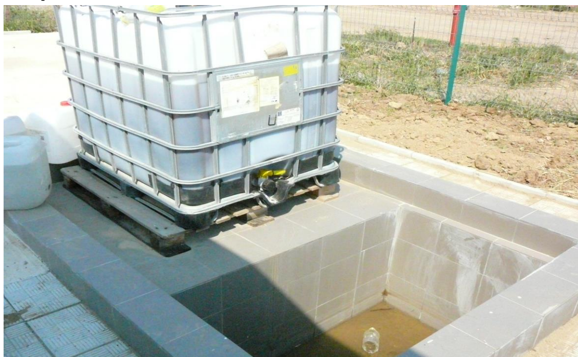
Figura nr. 5.9.6.-4. Bazin cuvă retenție
