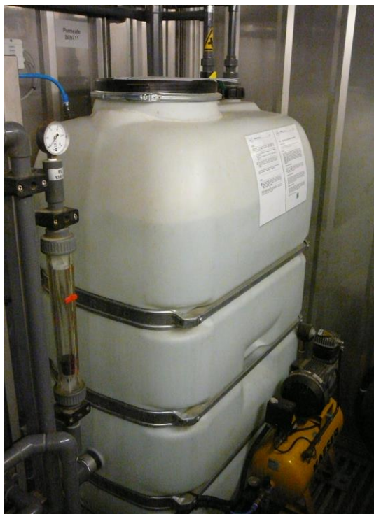
Fig. nr. 5.9.1.-8. Bazin condiționare PH permeat B09711
