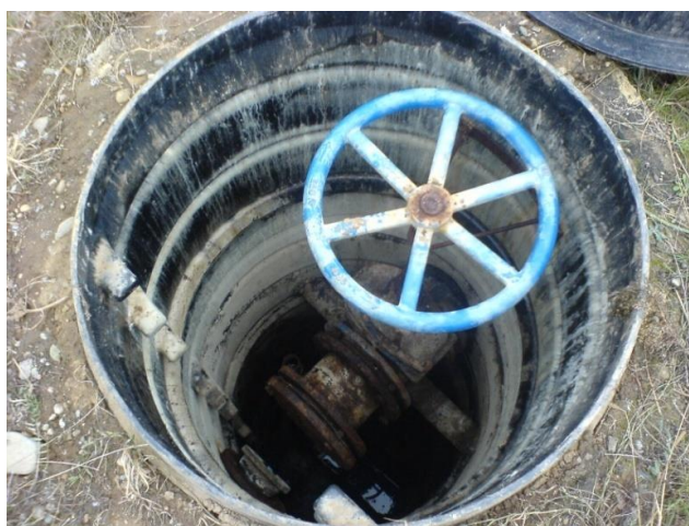
Figura nr. 3.4.5.12. -1. Cămin de colectare levigat
