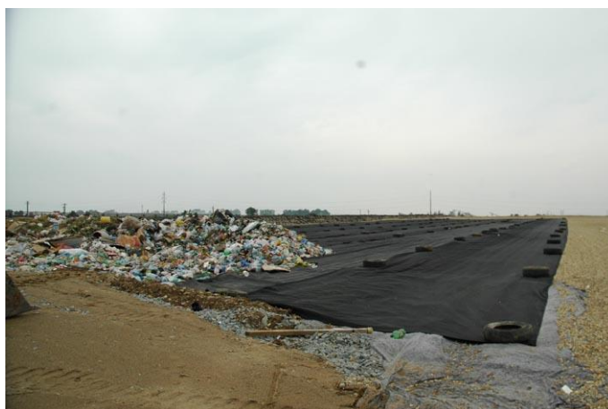
Figura nr. 3.4.5.8. -1. Așezarea geotextilei deasupra stratului de pietriș sor 16/32mm
