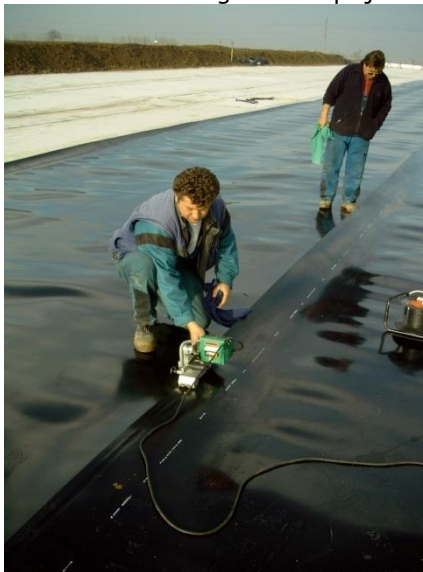
Figura nr. 3.4.5.5. -1. Sudarea geomembranei HDPE
