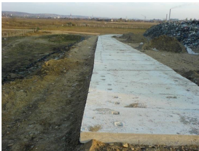
Figura nr. 3.4.11.5.-1. Rampa de acces în depozit
