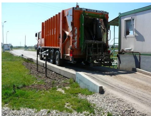
Figura nr. 5.6.1.-2.Cântărirea autoutilitarelor la ieșire din depozit
