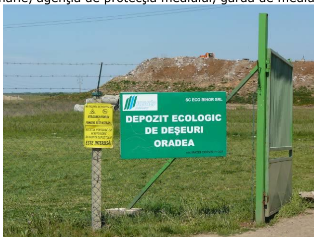
Figura nr.5.2.1.-1. Accesul în depozit
