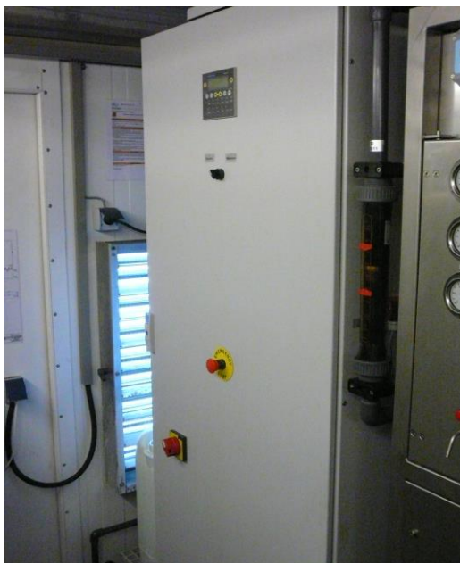
Figura nr. 5.9.1.-3. Unitatea de control și operare PLC
