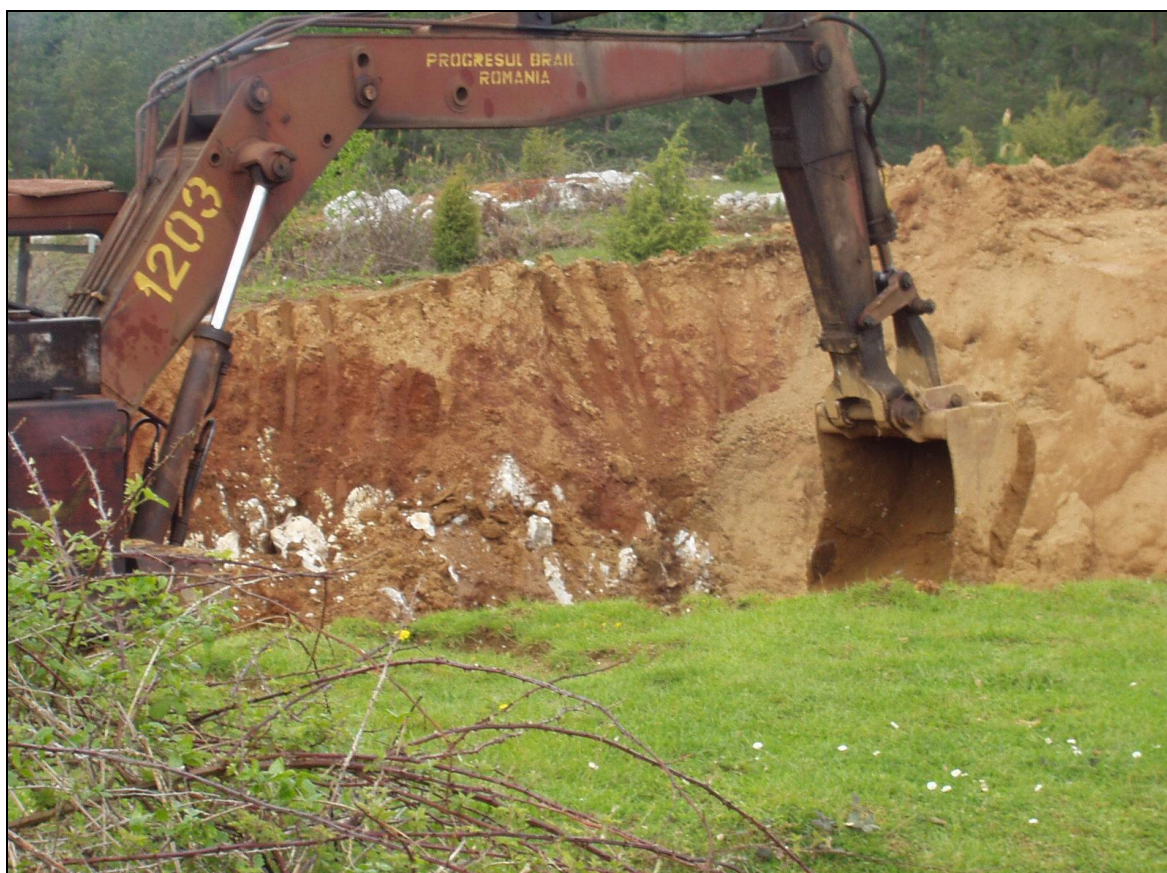
Figura 4.2. Aspect de la amenajarea fostei cariere de bauxită de la Zece Hotare, Bihor
