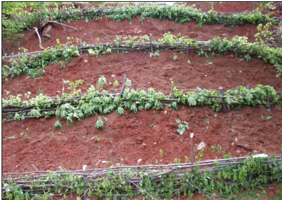
Figura 4.6. Cleionaje din fag după execuție (2004), în fosta carieră de bauxită de la Zece Hotare, Bihor
