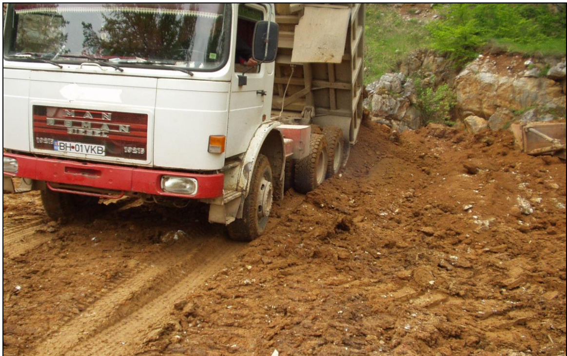
Figura 4.3. Aspect de la amenajarea fostei cariere de bauxită de la Zece Hotare, Bihor
