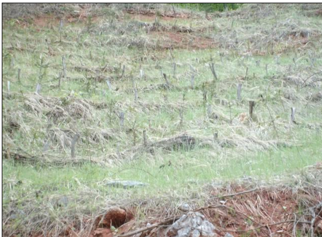
Figura 4.8. Versant amenajați cu cleionaje la 5 ani după execuție, în fosta carieră de bauxită de la Zece Hotare, Bihor
