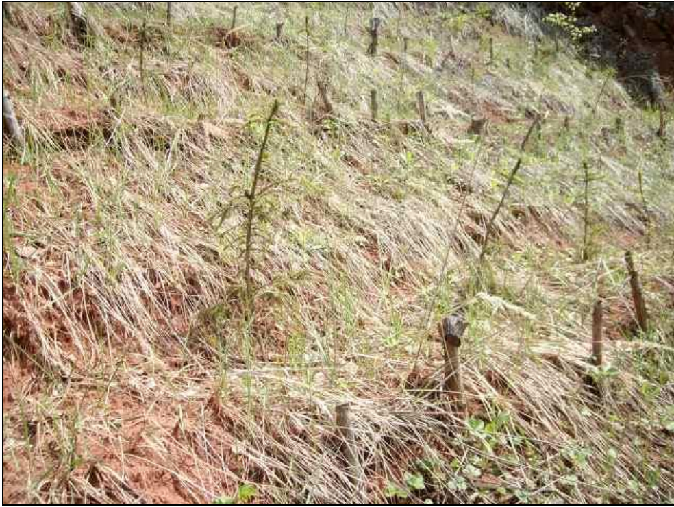
Figura 5.7. Aspect de eroziune pe versant plantat cu molid cu cleionaje din fosta carieră de bauxită de la Zece Hotare, Bihor 2008
