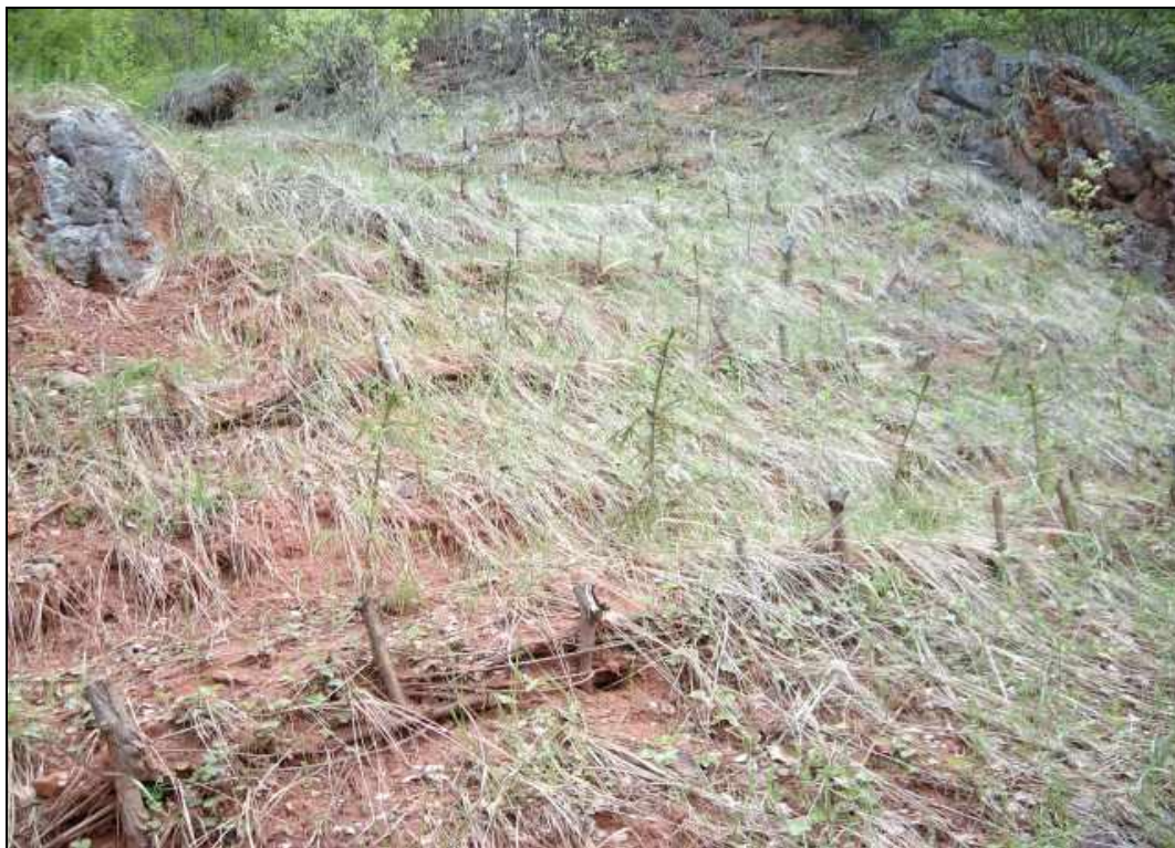
Figura 4.7. Versant amenajați cu cleionaje la 5 ani după execuție, în fosta carieră de bauxită de la Zece Hotare, Bihor
