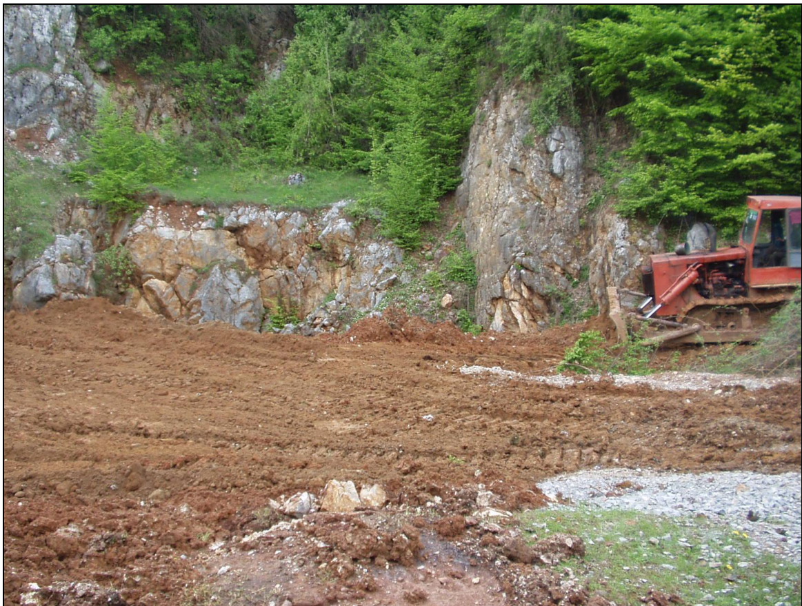
Figura 4.4. Aspect de la amenajarea fostei cariere de bauxită de la Zece Hotare, Bihor
