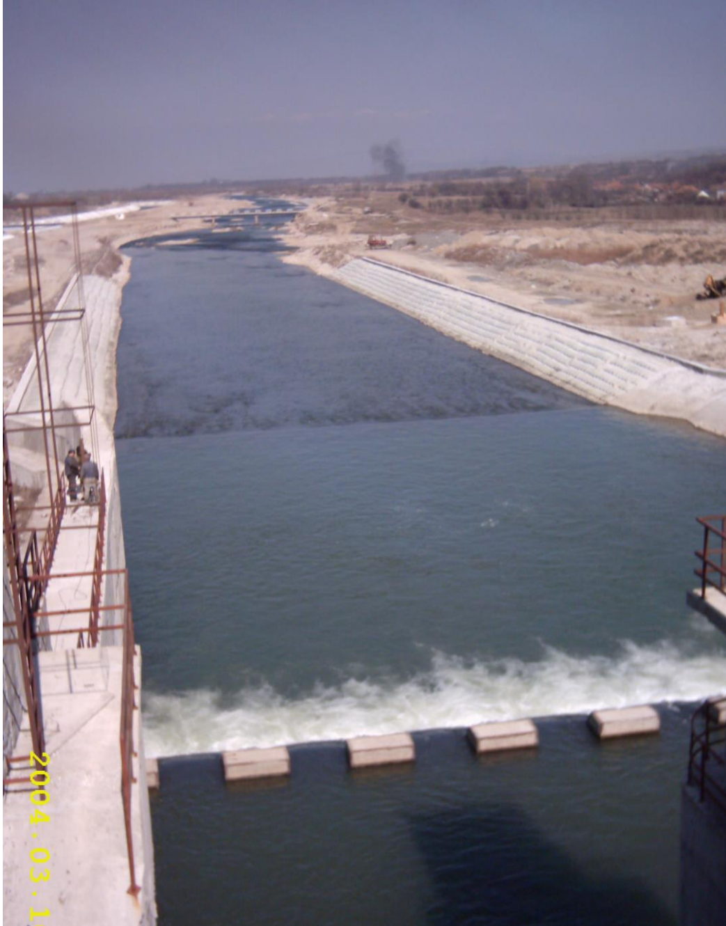
Fig. 1.3.4 - Vederea spre aval de pe centrala de la Subcetate
