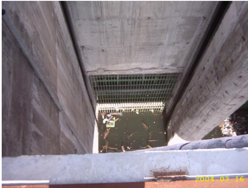
Fig. 1.3.6 - Imagine a grătarului dintre pile
