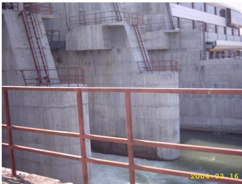
Fig. 1.3.9 - O vedere a modului de rezemare al stavilei pe culee;
