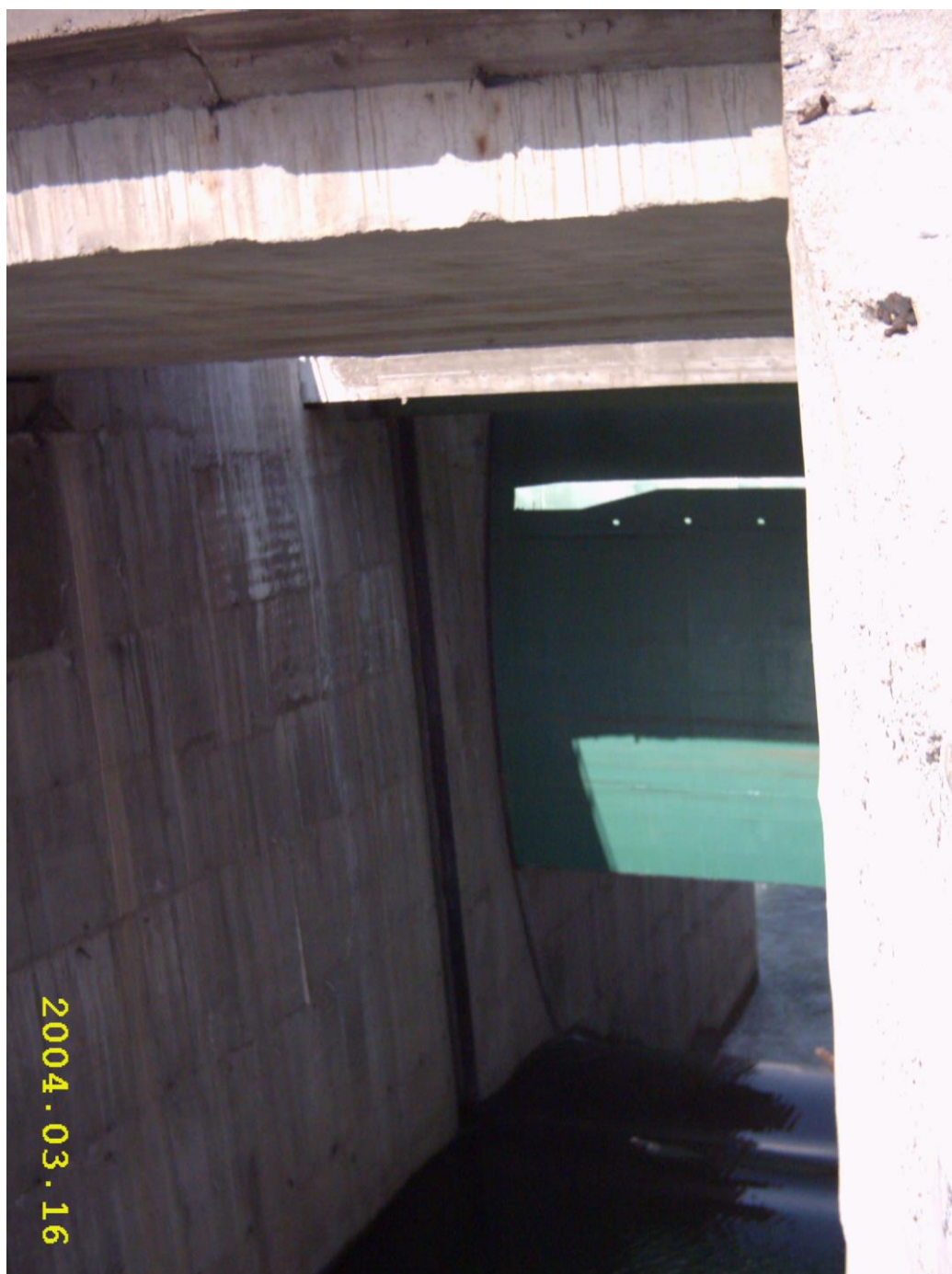
Fig. 1.3.7 – Vedere amonte a stăvililor
