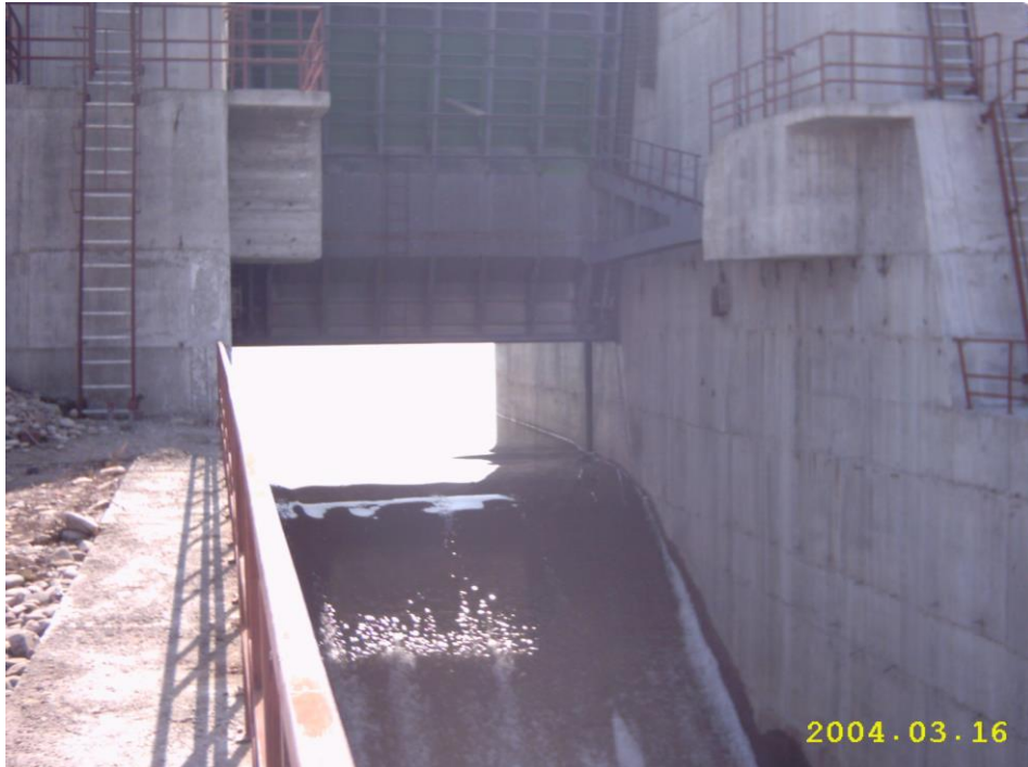
Fig. 1.3.8 - O vedere a pilelor din aval:
