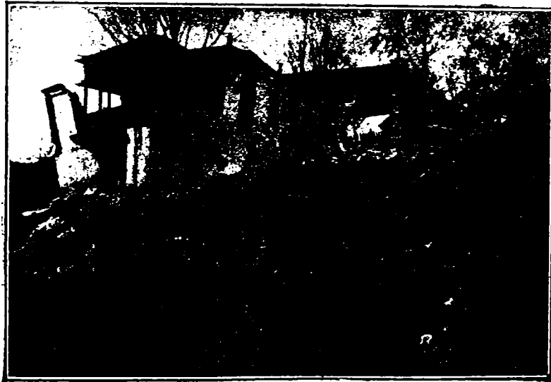
Fig. 90. — Casa D-lui Apostolescu din Provița de Sus, dărâmată din cauza unei alunecări în masă, în 1915.
