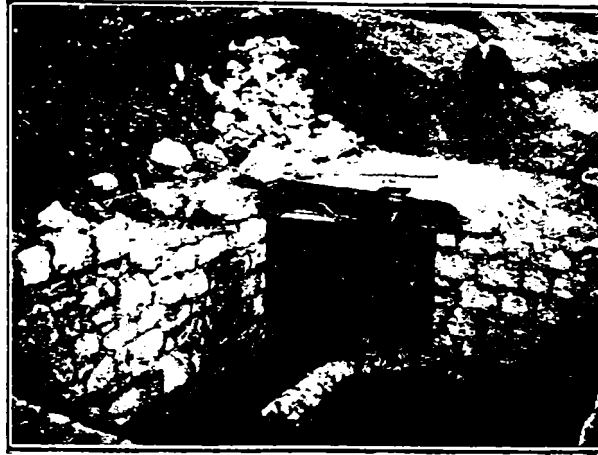
Fig. 99. — Lucrările de captare ale Topliței, sub vf. Mateiașul, în Muscel.
