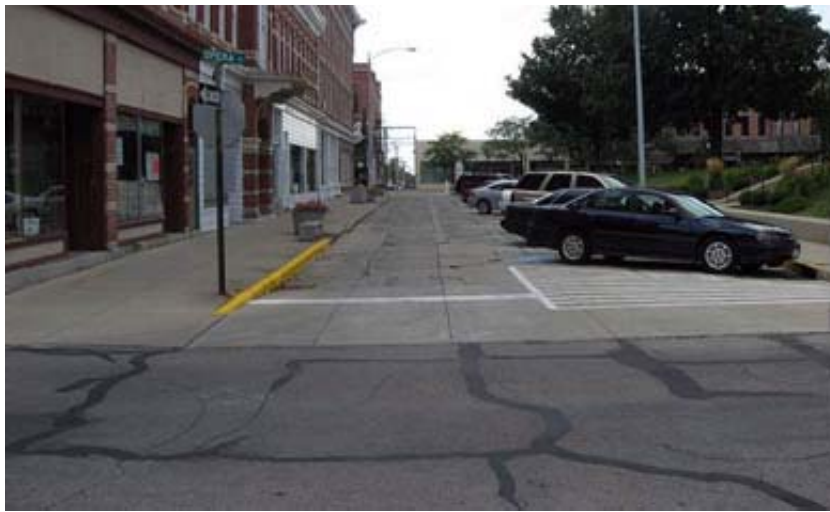
Fig. 1. Bellefontaine, Ohio, United States [1] – prima stradă betonată din America
