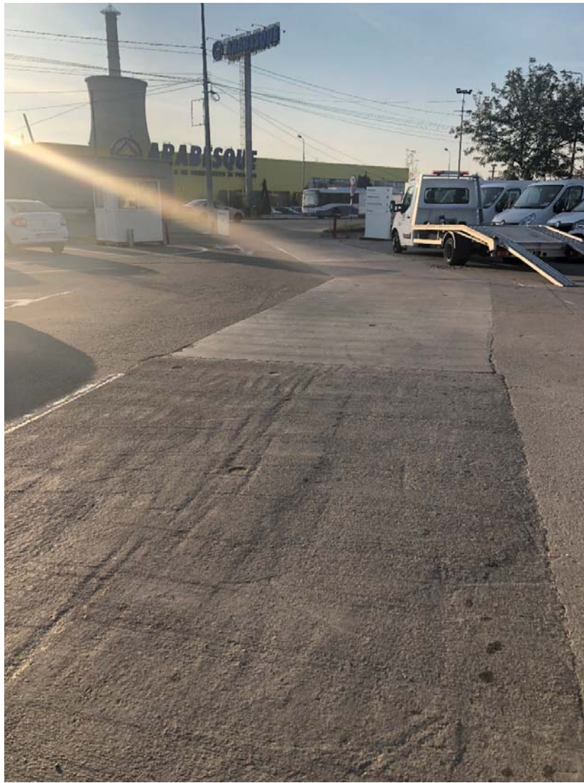
Figura 48 a. Platforma reabilitată, vârsta 5 ani
