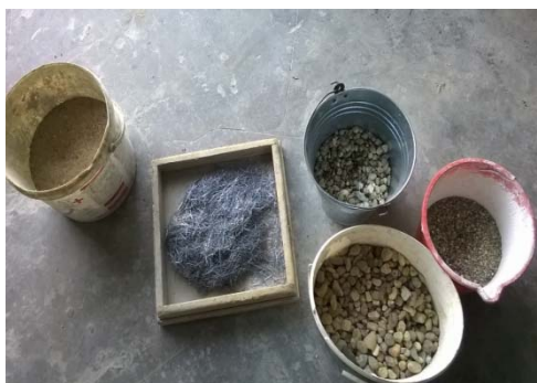
Figura 22. Materiale folosite la prepararea betoanelor cu fibre metalice
