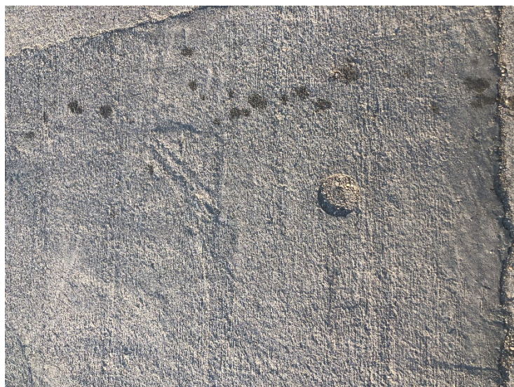
Figura 48 c. Platforma reabilitată zona fibre polimerice pe toată grosimea, respectiv pe 5 cm grosime
