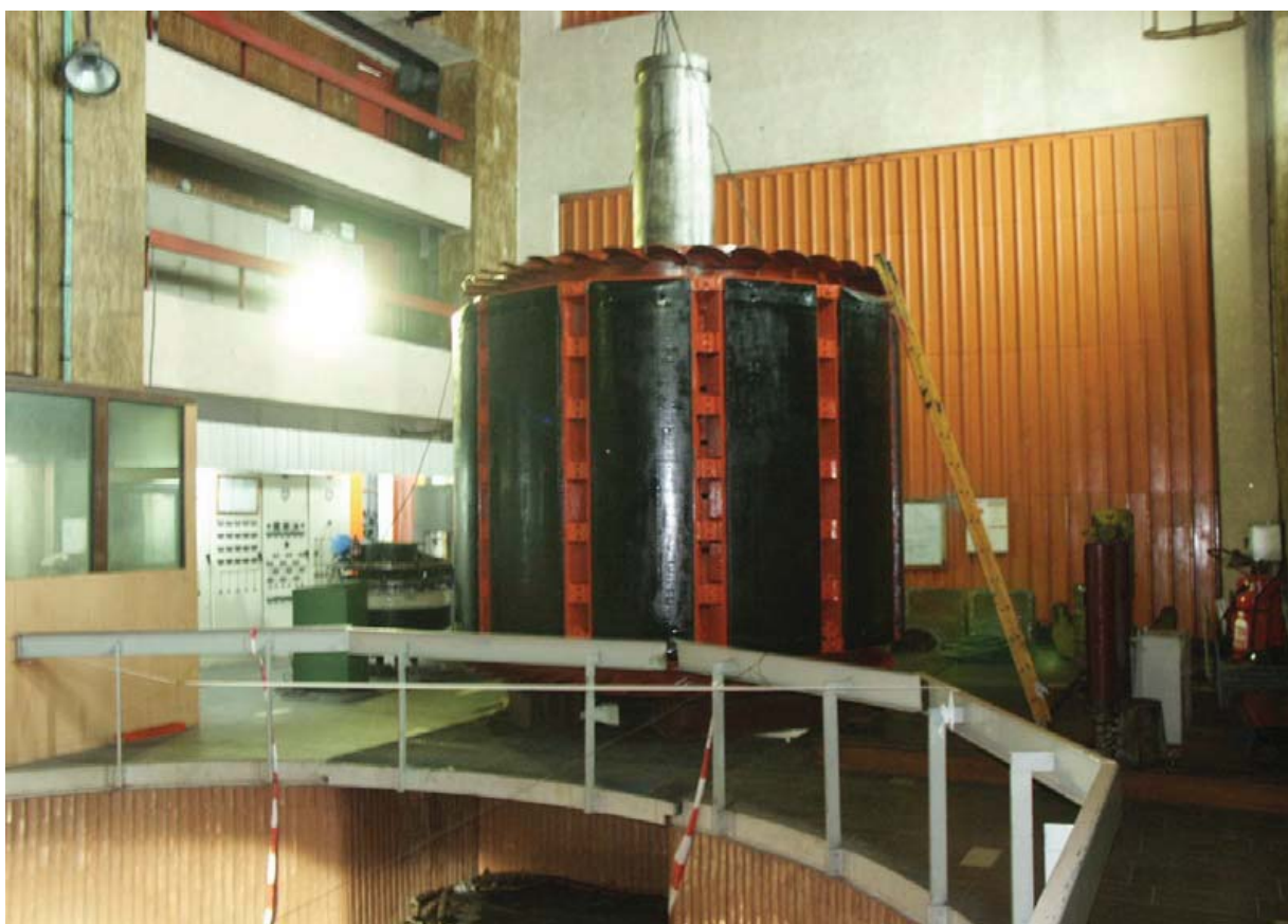
Fig. 3.3- Rotorul generatorului
