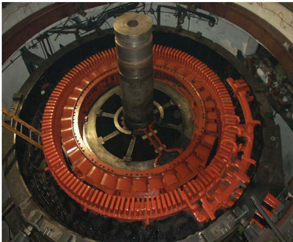
Fig. 3.8 – Vedere de sus a ansamblului rotor-stator, palele ventilatorului superior.
