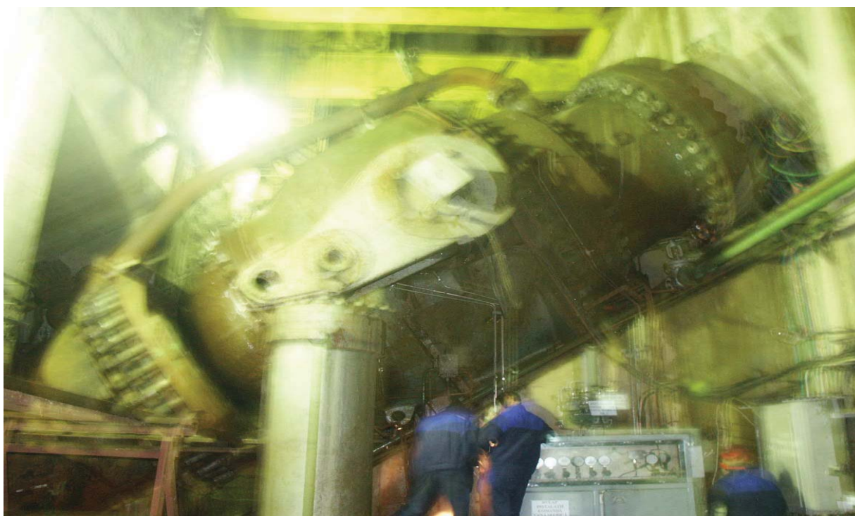
Fig. 2.9- Vana sferică în timpul unei reparații.
