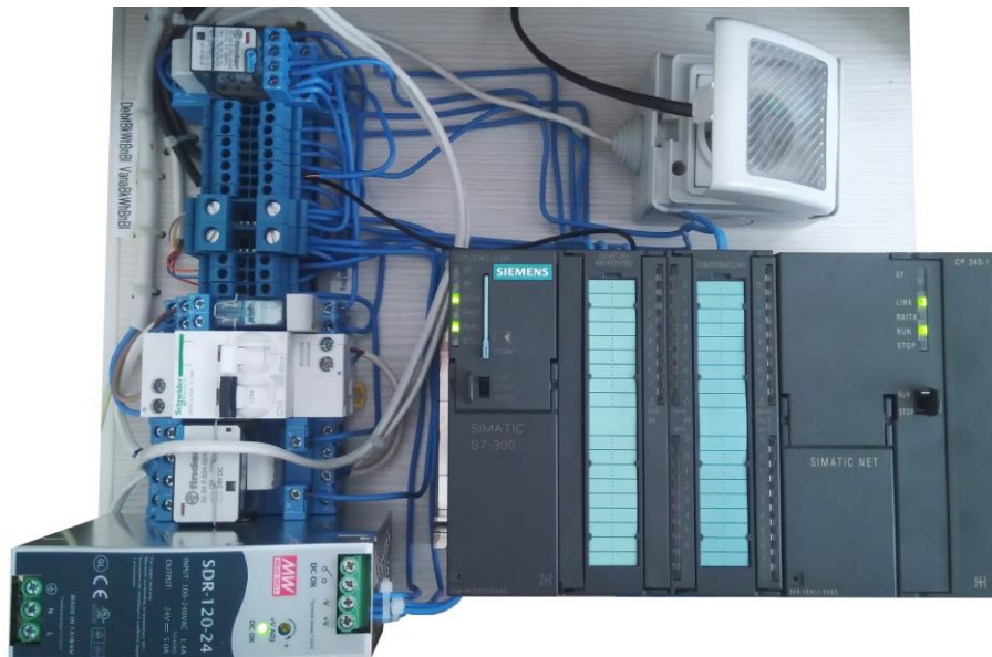
Fig. 6.13 Conexiunile PLC-ului
