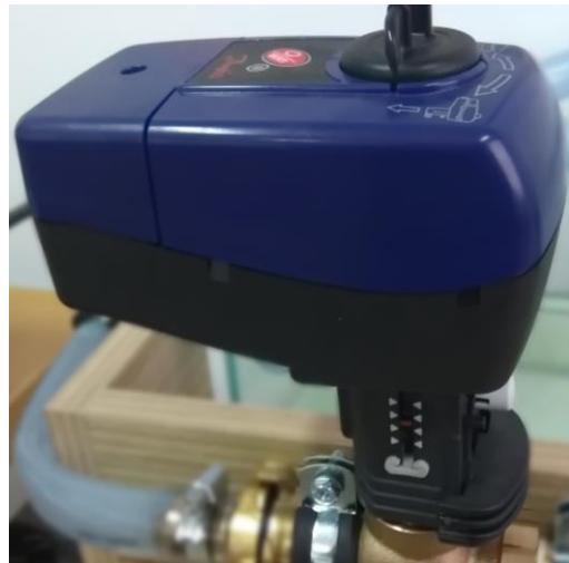
Fig. 6.4 Element Danfoss AB-QM DN10-250
