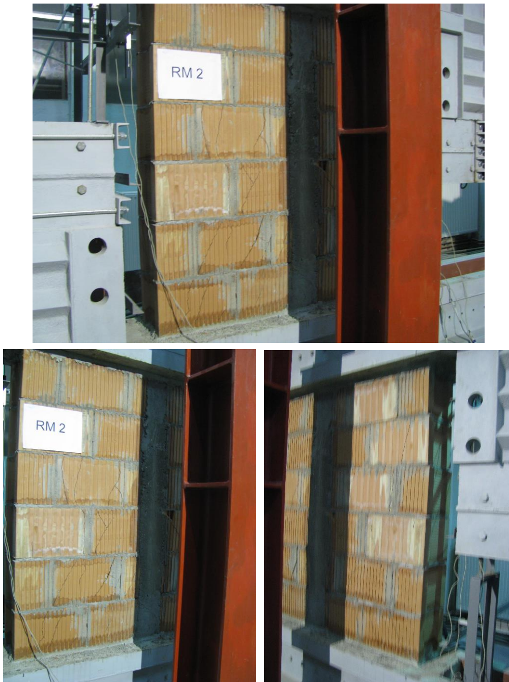
Fig. 5.21. Avarii ale elementului RM2 – zidărie confinată cu stâlpișor central
