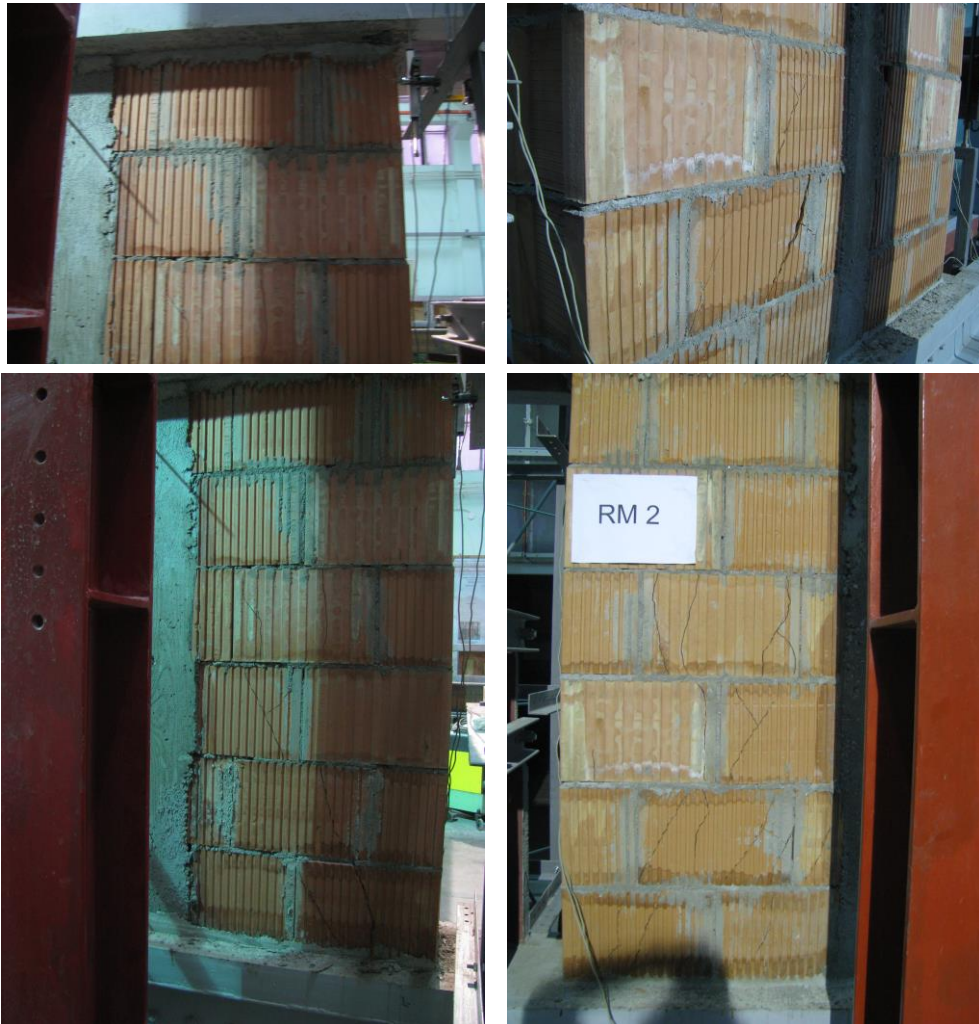
Fig. 5.22. Avarii ale elementului RM2' – zidărie confinată cu stâlpișor central
