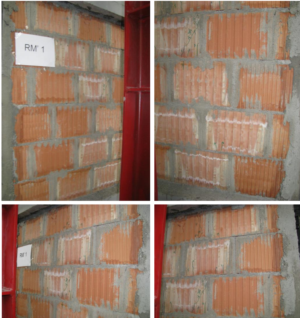
Fig. 5.13. Avarii ale elementului RM1' – zidărie confinată cu stâlpișori laterali
