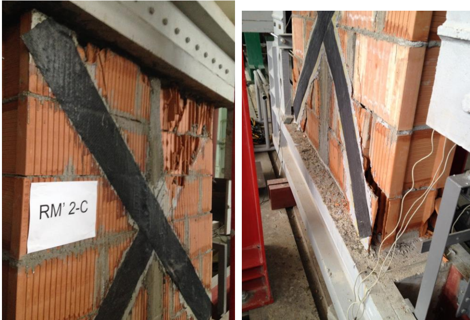
Fig. 5.49. Avarii ale elementului RM2'-C – zidărie confinată cu stâlpișor central consolidată
