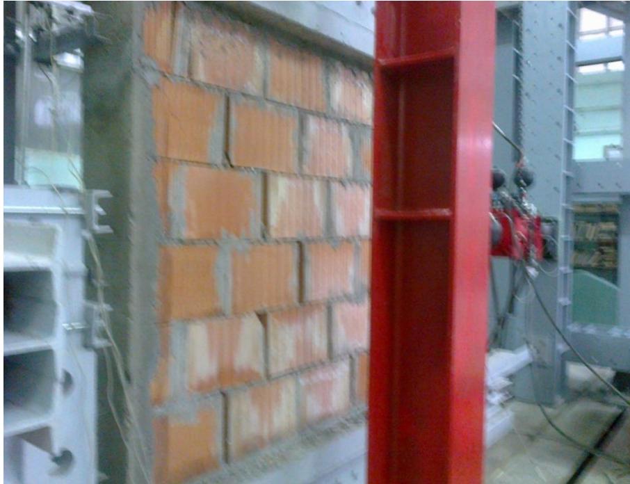
Fig. 5.14. Avarii ale elementului RM1" – zidărie confinată cu stâlpișori laterali
