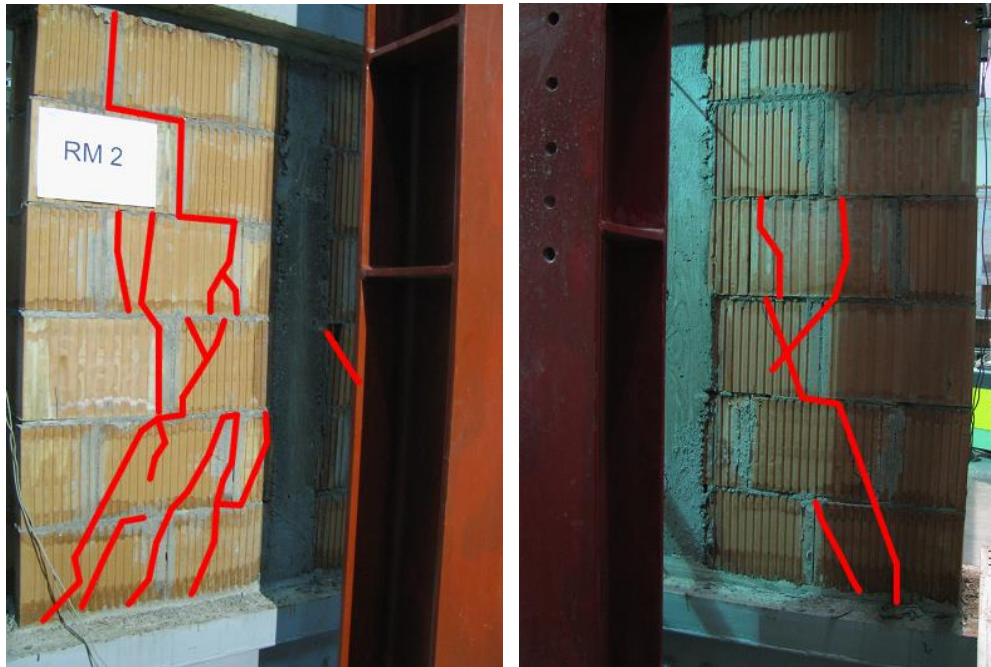
Fig. 5.69. Fisuri element din zidărie confinată cu stâlpișor central
