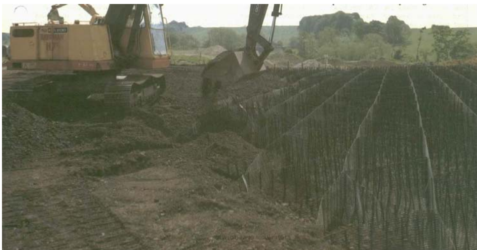
Fig.8.23. Modalitate de umplere a geocelulelor
