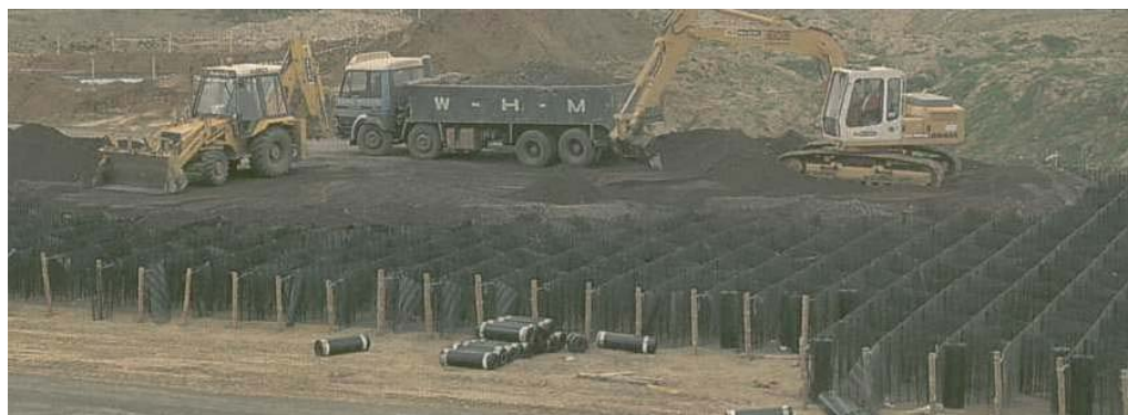
Fig.8.22. Aspecte de santier privind realizarea geocelulelor
