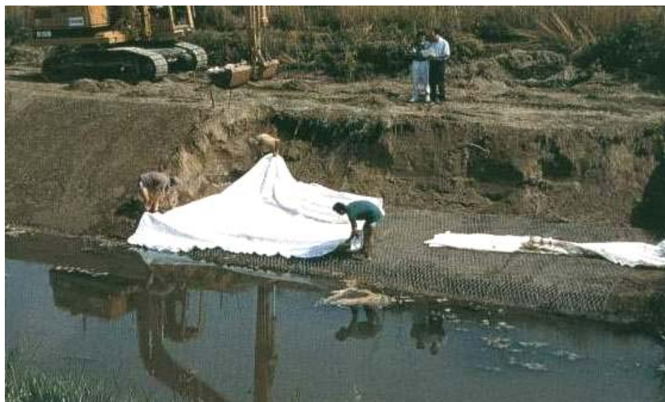
Fig.8.30. Soluție originală pentru apărări de maluri, folosind geotextil încapsulat în taluz
