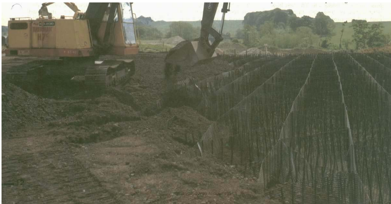
Fig.8.36. Umplerea geocelulelor cu pamint sau piatra sparta
