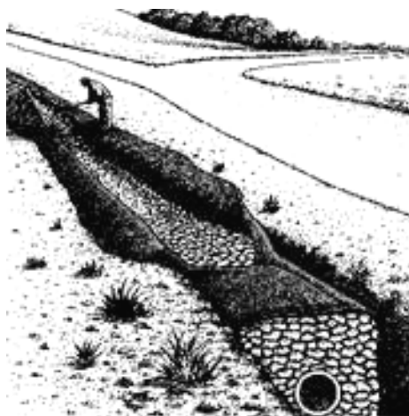
Fig.8.2. Captarea excesului de apă din precipitații
