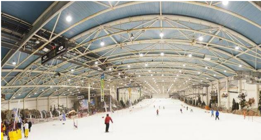
Figura 51 Complexul comercial Xanadu Madrid –pista de schi funcționează tot anul, indiferent de condițiile climatice exterioare
