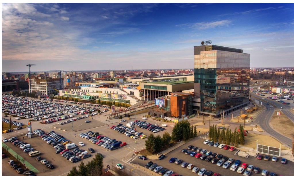
Figura 95 Julius Mall Timișoara în anul 2017 – clădirea UBC1 în șantier, clădirea UBC2 finalizată flanchează fațada estică a clădirii inițiale Sursă : http://openville.ro/gallery/ro/8/GALERIE-FOTO.html accesat 13.09.2017
