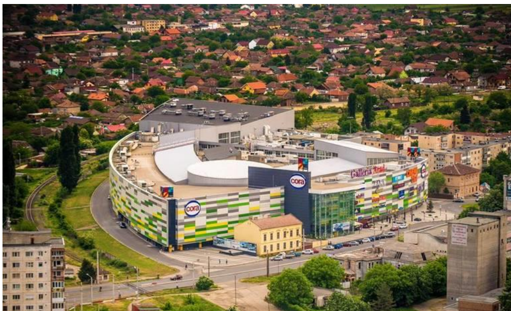
Figura 103 Mallul Galleria Arad- a intrat începând cu anul 2015 (la doar 4 ani de la inaugurare) într-o stare avansată de abandon odată cu plecarea ancorei principale hipermarketul Cora
