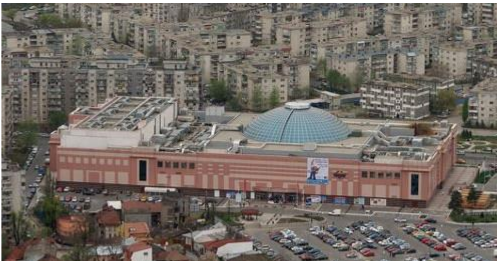
Figura 67 București Mall înainte de extinderea din 2007, imaginea surprinde relația față de fondul construit existent, regimul real de înălțime surprins în context
