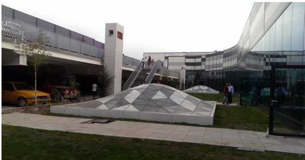
Figura 80 Terasă Mega Mall București – imagine care surprinde relația cu parcajul Sursă: http://www.hotnews.ro/stiri-administratie_locala-20134792-fotogalerie-mega-mall-noul-mall-din-cartierul-bucurestean-pantelimon-fost-inaugurat-joi-vezi-cum-arata-magazine-gazduieste.htm accesat 07.06.2017
