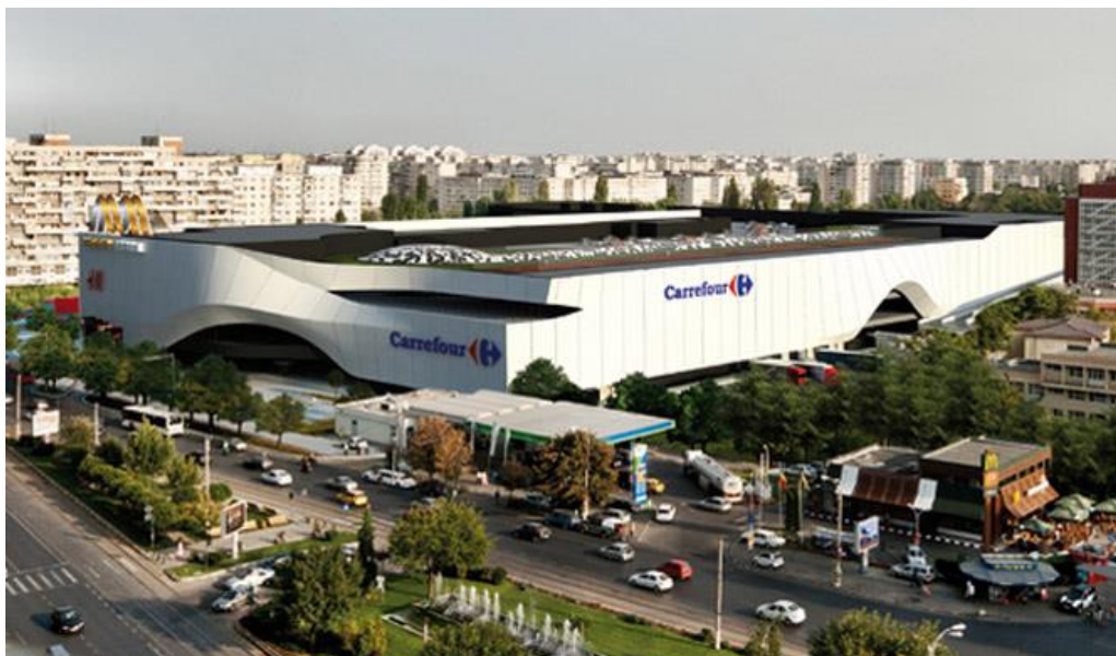
Figura 82 Mega Mall București - clădirea desprinsă de împrejurimi prin fațadele sale oarbe, dar și prin nepotrivirea de scară
