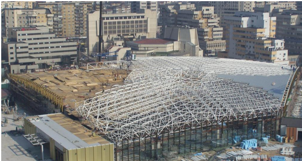
Figura 2 Imagine din șantierul Palas Mall Iași 03.2012 – montarea structurii de acoperire peste atriumul principal al centrului comercial
