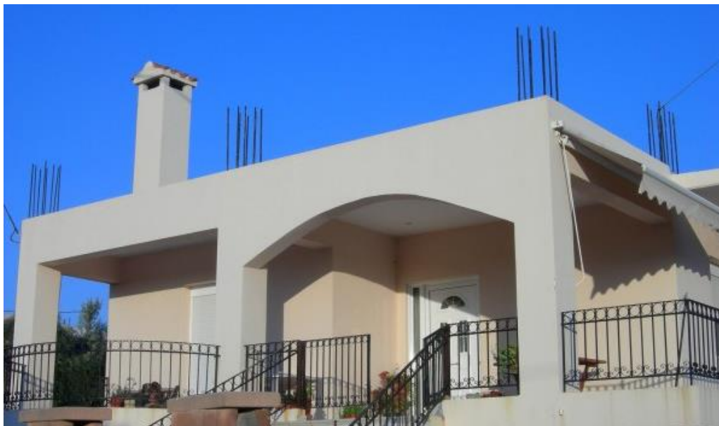
Figura 122 Casă în Grecia, mustățile armăturii sunt lăsate pentru a permite supraetajare ulterioară
