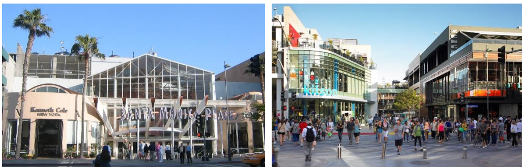
Figura 120 Santa Monica Place înainte și după intervenția din 2010
