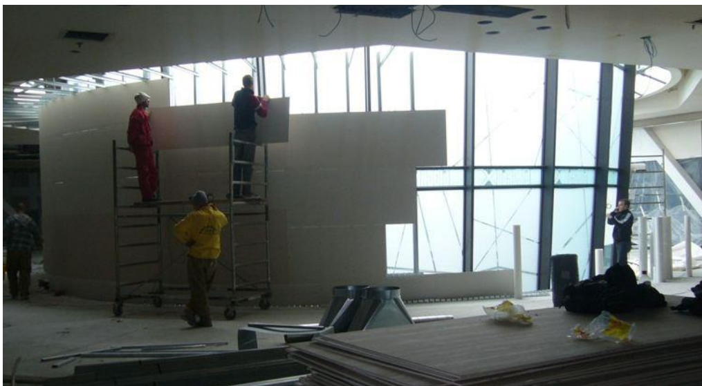
Figura 91 Închiderea luminatorului central- zona corp H
