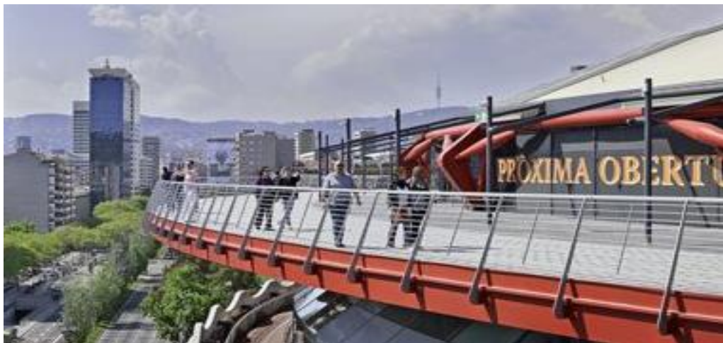
Figura 45 Terasa publică ce oferă o vedere panoramică asupra orașului Barcelona Sursă : https://www.dezeen.com/2011/05/27/las-arenas-by-rogers-stirk-harbour-partners/ accesat 10.03.2017
