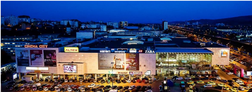
Figura 70 Iulius Mall Iași după extinderea din 2008
