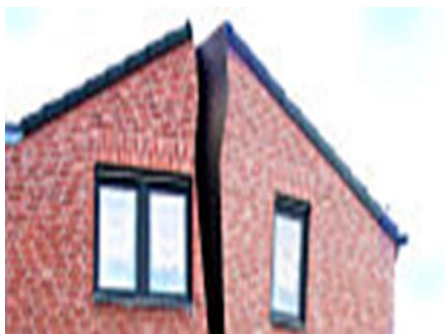
Fig. 4.7. Clădire rezidențială, Despărțire verticală [33]
