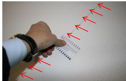
Fig. 11.9.b. Hală reparații fisuri 0,3mm
