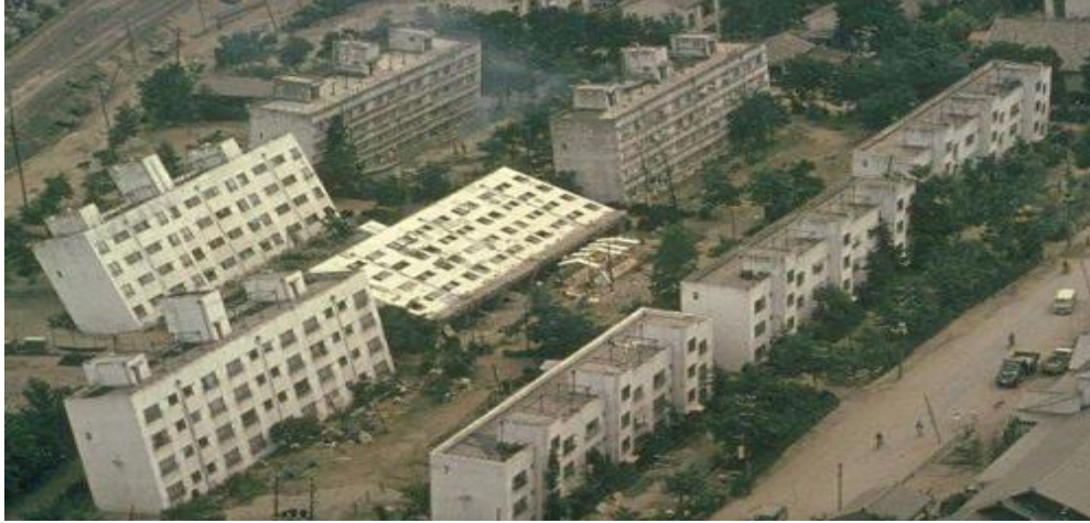
Fig. 4.4. Prăbușire clădiri, Niigata / Japan [71]
