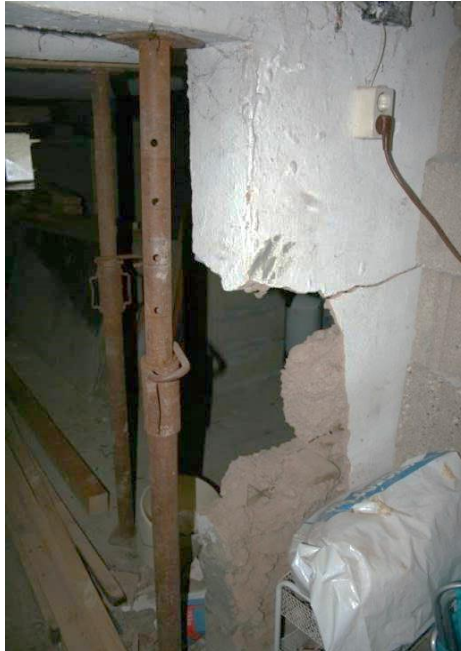
Fig. 5.7. Cedarea unei structuri de rezistență
