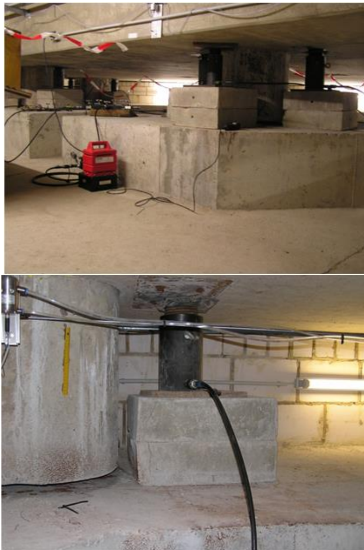
Fig. 8.15.a,b. Instalația hidraulică [8]
