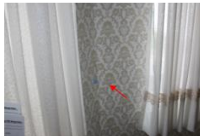
Fig. 7.2. a,b,c,d Fisuri în pereții de rezistență
