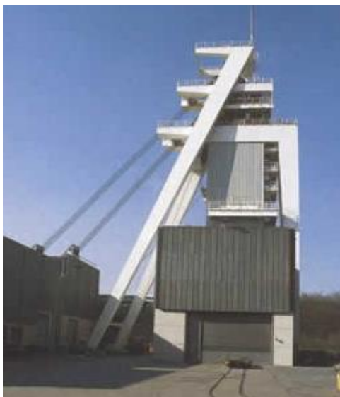
Fig. 1.7. Puțul de Nord; Mina Ensdorf [31]
