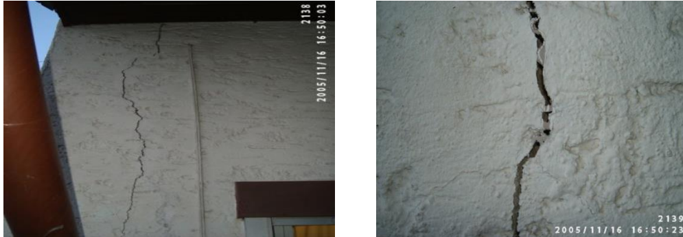
Fig. 11.3. Perete posterior al clădirii de locuit
