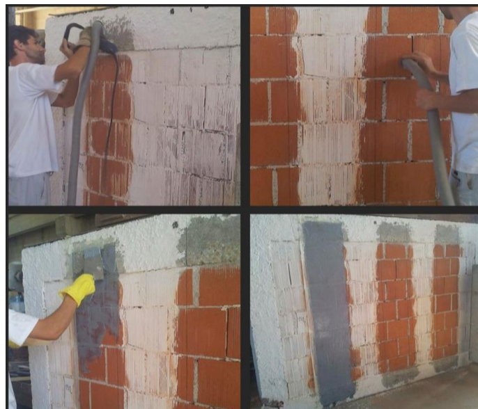
Fig. 4.39. Pregătirea suprafeței și aplicarea adezivului
