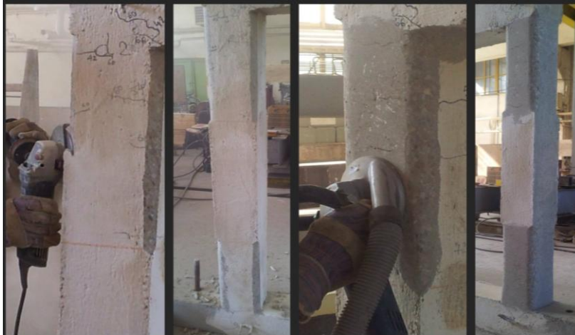
Fig. 4.30. Pregătirea suprafeței pentru aplicarea lamelelor și țesăturii
