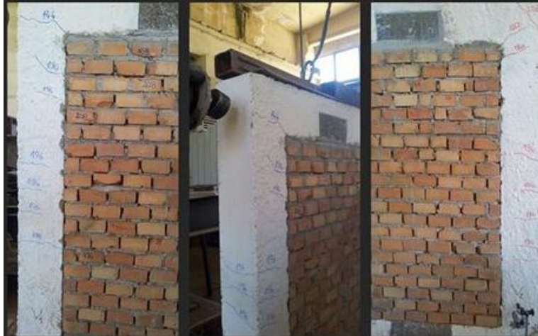
Fig. 4.44. Presentarea cadrului cu mustăți de ancorare umplut cu cărămidă plină după apariția fisurilor
