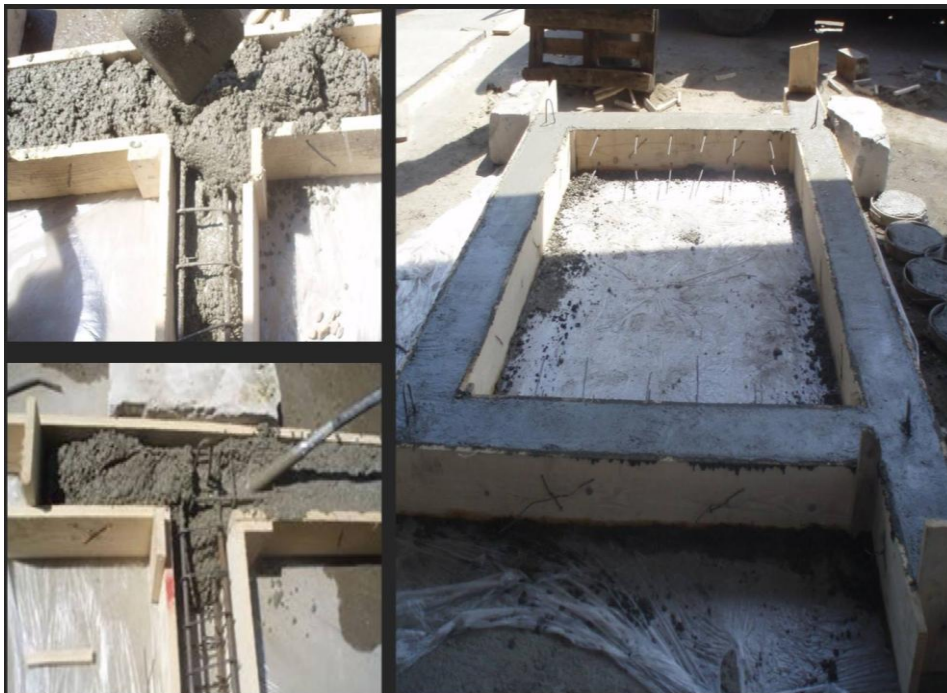
Fig. 4.21. Turnarea și vibrarea betonului
