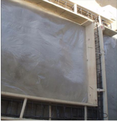
Fig. 4.19. Cofrarea și armarea cadrului fără mustăți de ancorare a zidăriei
