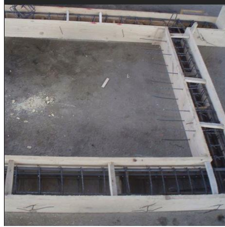
Fig. 4.20. Cofrarea și armarea cadrului cu mustăți de ancorare a zidăriei
