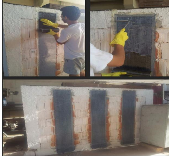
Fig. 4.40. Aplicarea țesăturii Sika Wrap
