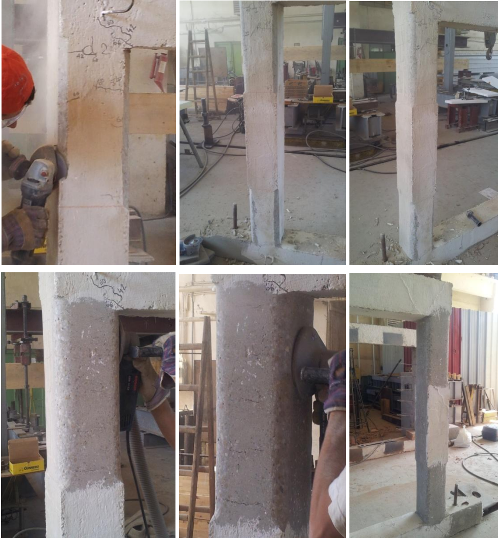
Fig. 3.25. Pregătire stâlp pentru cămășuire cu polimeri armați cu fibre (FRP) (arhiva personală)
