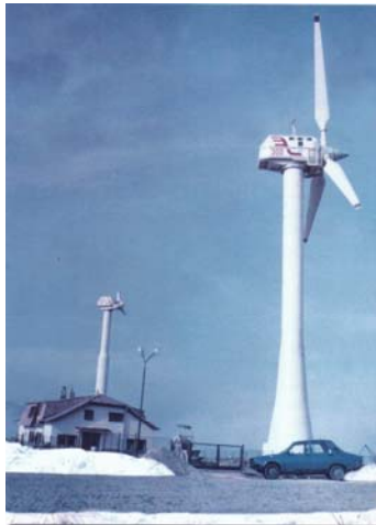
Fig. 2.1.2. Semenic, Munții Banatului [Bud 2009]: (a) ferma eoliană; (b) AAE cu DFIG de 300kW.
