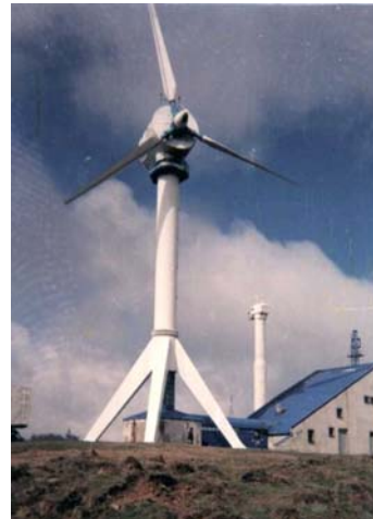
Fig. 2.1.2. Semenic, Munții Banatului [Bud 2009]: (a) ferma eoliană; (b) AAE cu DFIG de 300kW.
