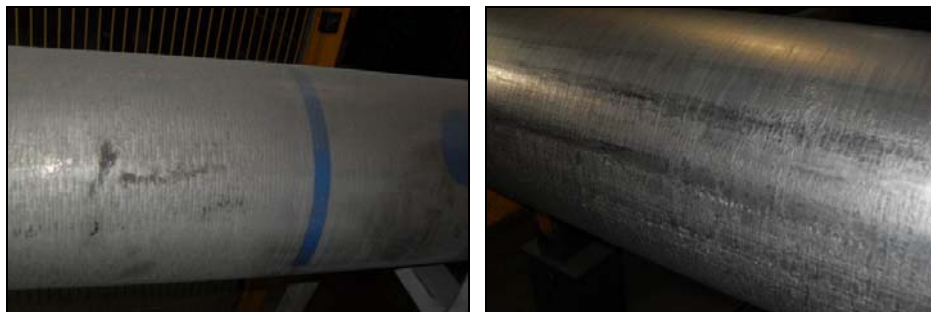
Fig. 5.22. Bare cu defecte
