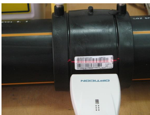
Figura 3.15 Identificarea fittingului prin citirea codului cu bare
