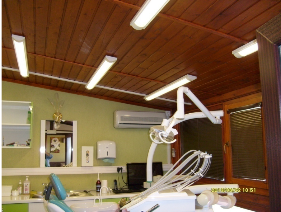
Fig. 3.4. Corpuri de iluminat în cabinet dentar.
