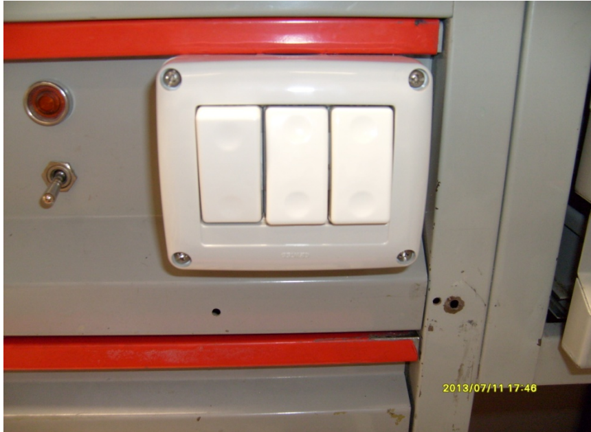
Fig. 5.21. Comanda instalației de iluminat din „CAMERA CERAMICĂ”.
