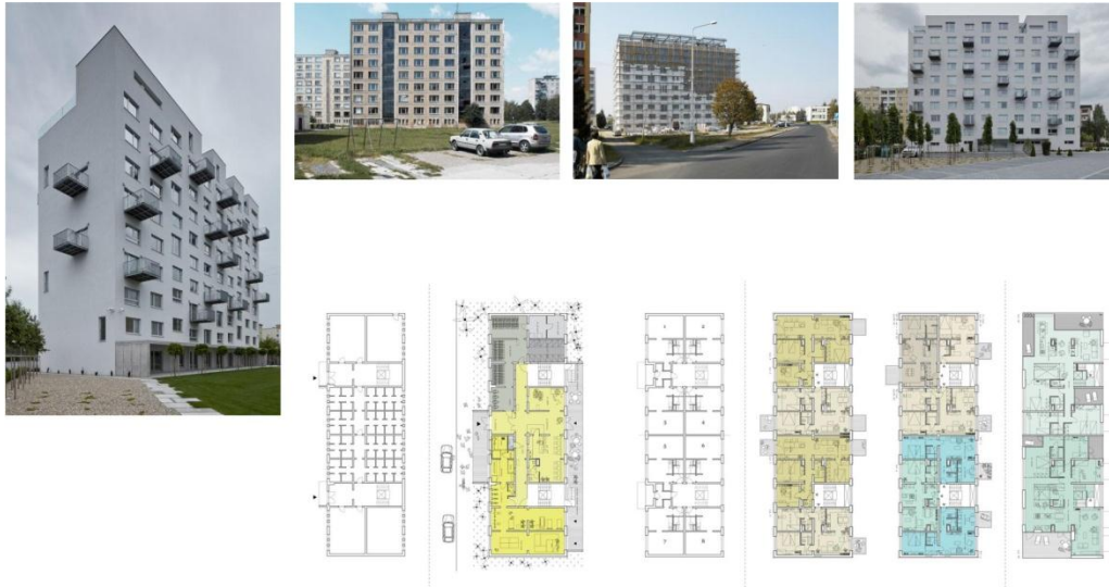
3. Reabilitare bloc din panouri mari prefabricate în Rimavska Sobota , Slovacia // proiectant: GutGut Architects
