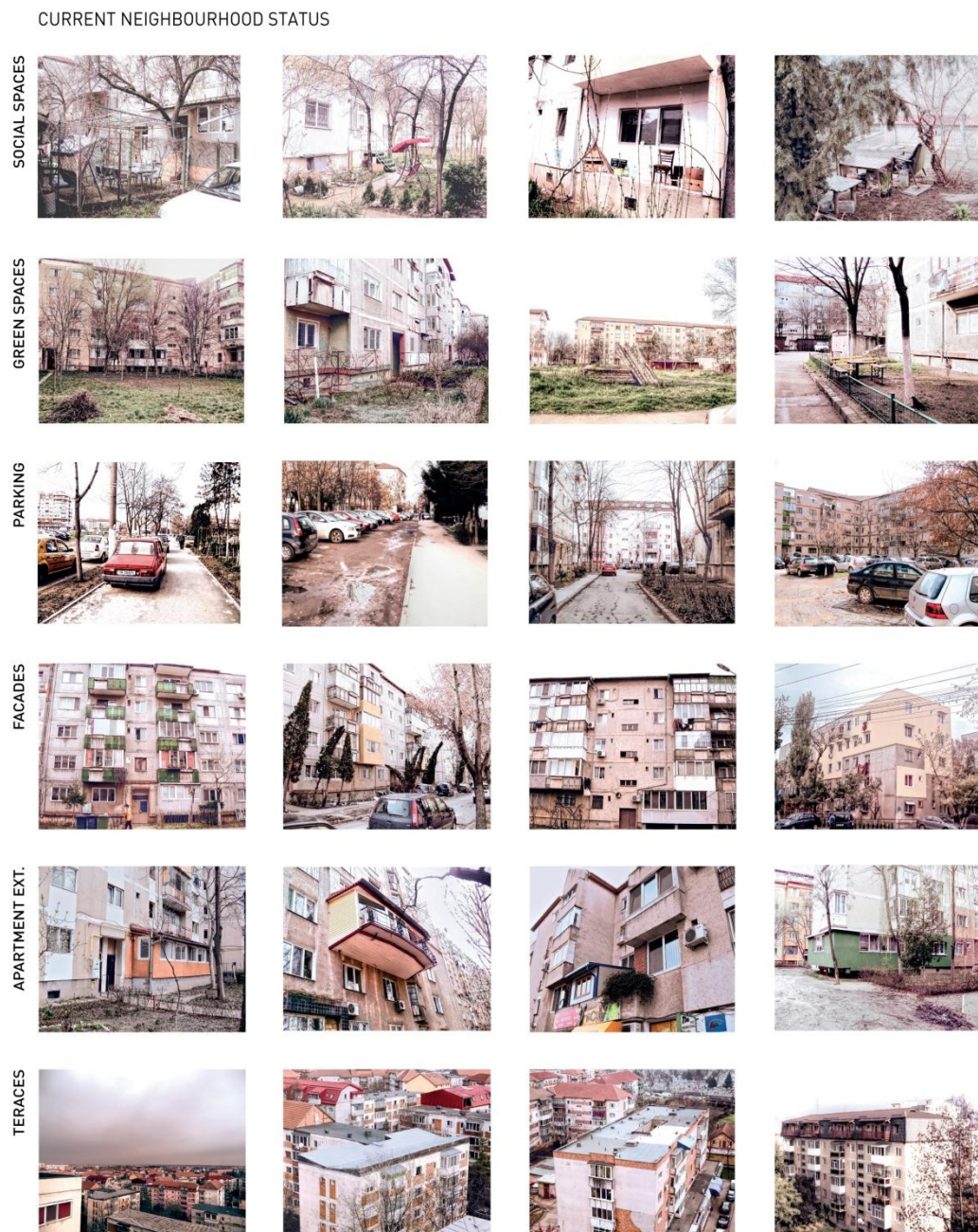
Figura 40. Intervenții curente asupra blocurilor din panouri mari prefabricate
