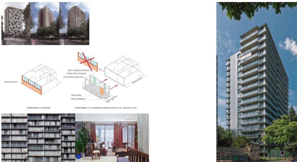
2. Reabilitare bloc din panouri mari prefabricate - Tour Bois-Le-Prêtre, Paris, Franța // proiectant: Lacaton-Vassal
