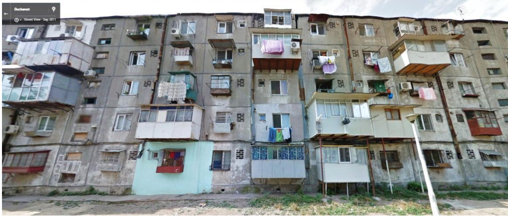
Figura 45. Varietatea extinderilor orizontale – cartierul Ferentari, București
