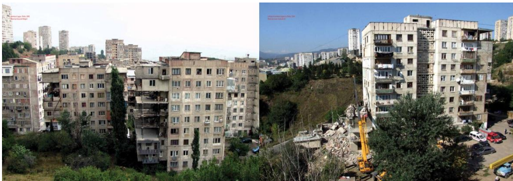
Figura 48. Prăbușirea extinderilor orizontale improvizate, Tbilisi, Georgia 2009
