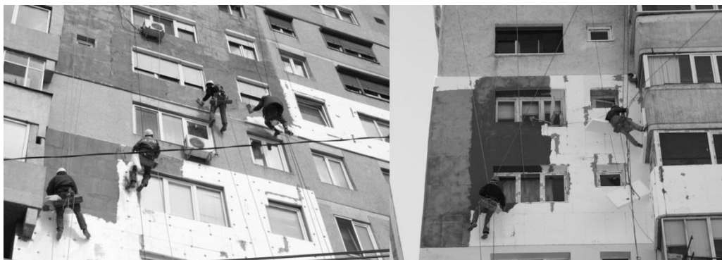
Figura 38. Lucrări atipice de reabilitarea termică
