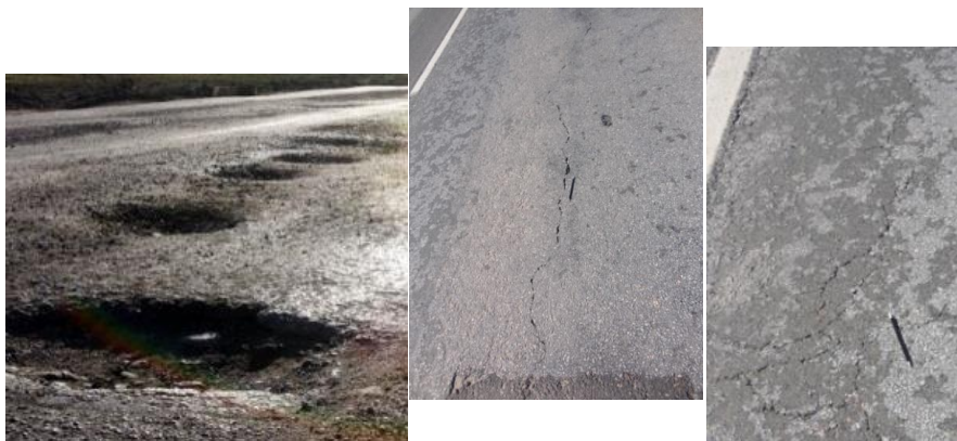
Fig.4.10. a) Gropi, b) Fisuri și crăpături longitudinale, c) Fiațări
