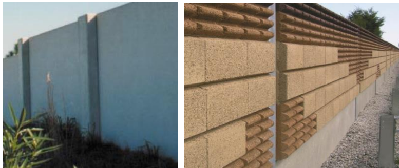
Fig.4.5. Panouri din beton și panouri compozite
