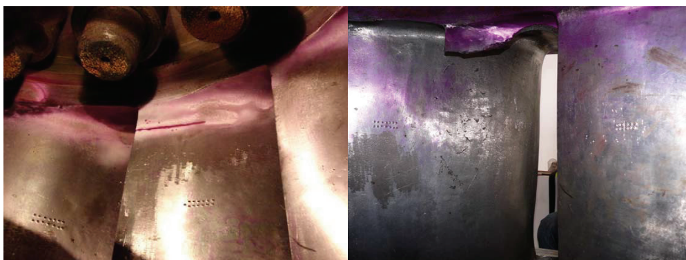
Fig.1.23. Fisură (stânga) și rupere a paletel (dreapta) de turbină Francis [45]
