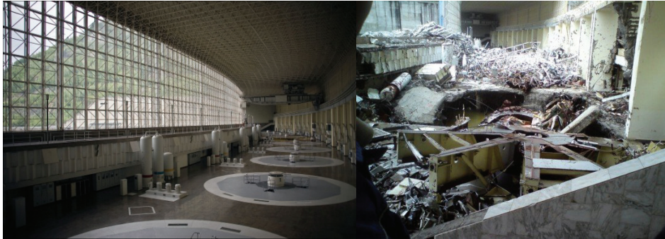
Fig.1.24. Interiorul hidrocentralei Sayano – Shushenskaya înainte și după accident [157]
