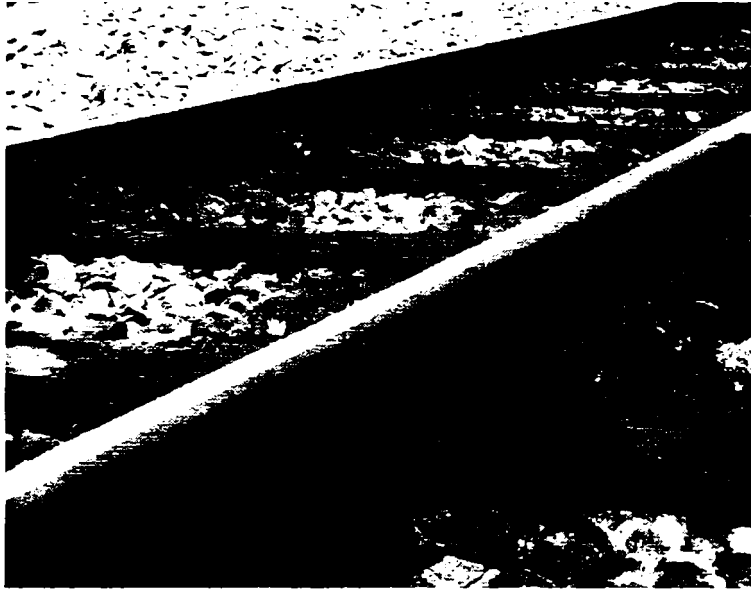
Fig. 4. 29. Izolare fonică a inimii șinei [45]
