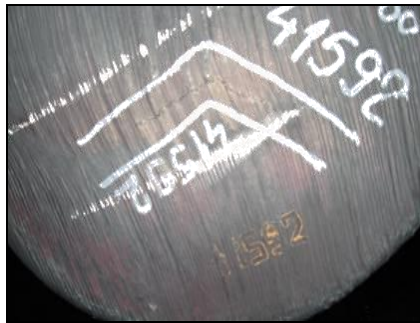
Fig.6.8. Fisuri interne la centru, [18]
