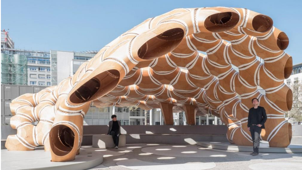
Figură 4.53 Pavilion ICT/ITKE 2015
