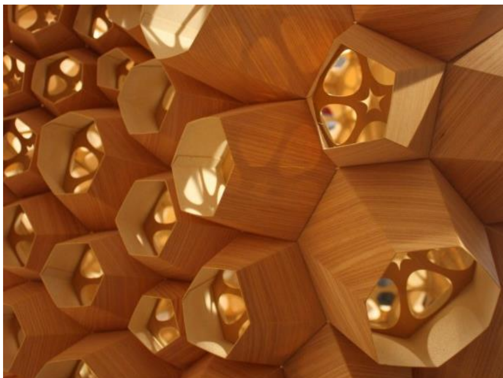
Figură 4.25 Andrew Kudless, instalație „Chrysalis III”. Exemplu de rezolvare a îmbinărilor în corelare cu forma generată
