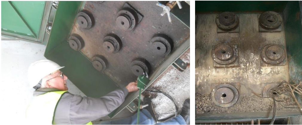
Fig. 4.7. Inspectarea "in situ" a ancorajelor din capătul pilonului
