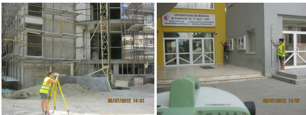
Fig. 5.12. Observații efectuate prin metoda nivelmentului geometric
