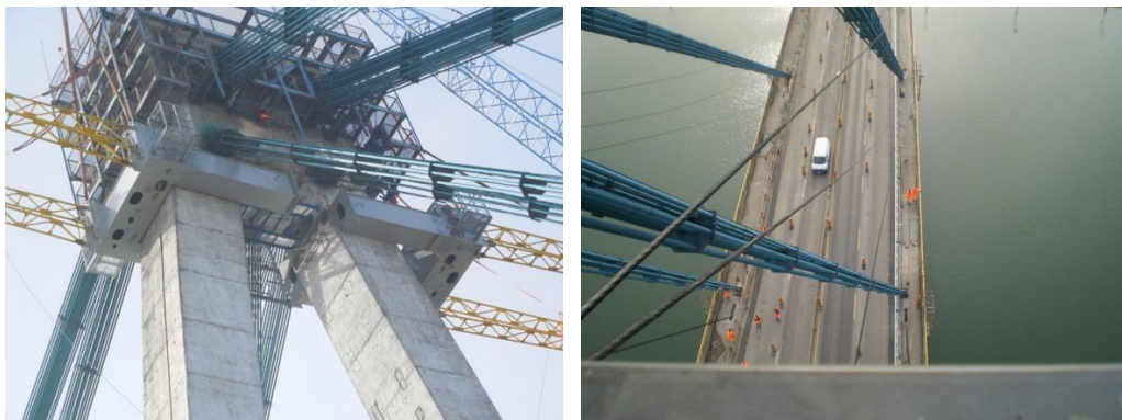
Fig. 4.34. Montarea jugului în partea superioară a pilonului și ridicarea toroanelor
