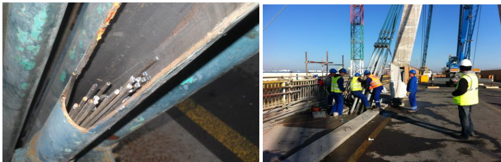
Fig. 4.37. Dezafectarea hobanelor existente și montarea hobanelor noi
