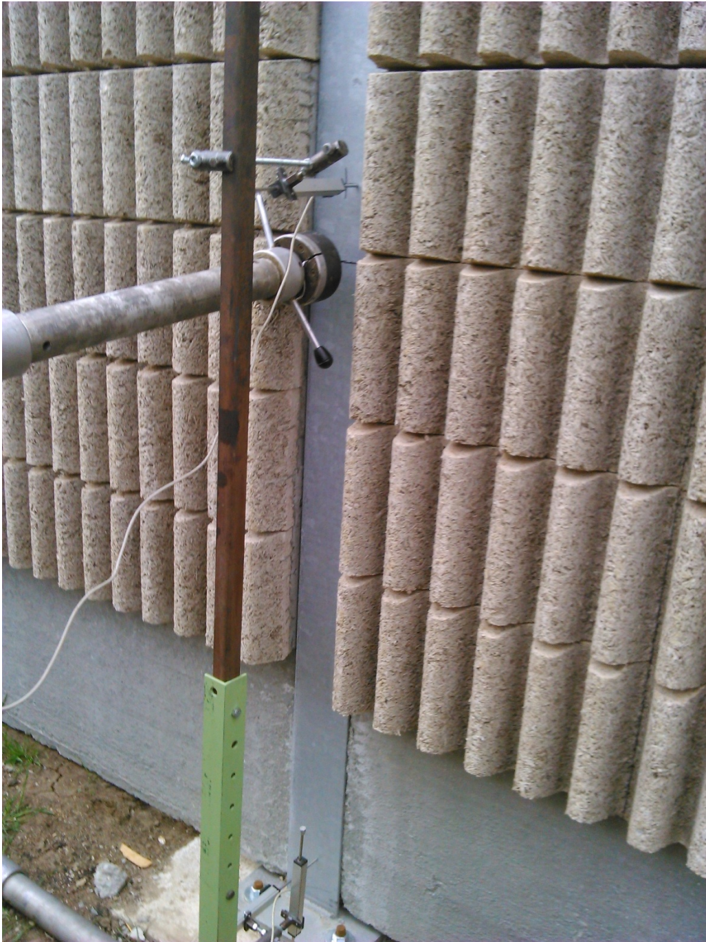
Fig. 6-2. Vedere dispunere echipamente testare si măsurare
