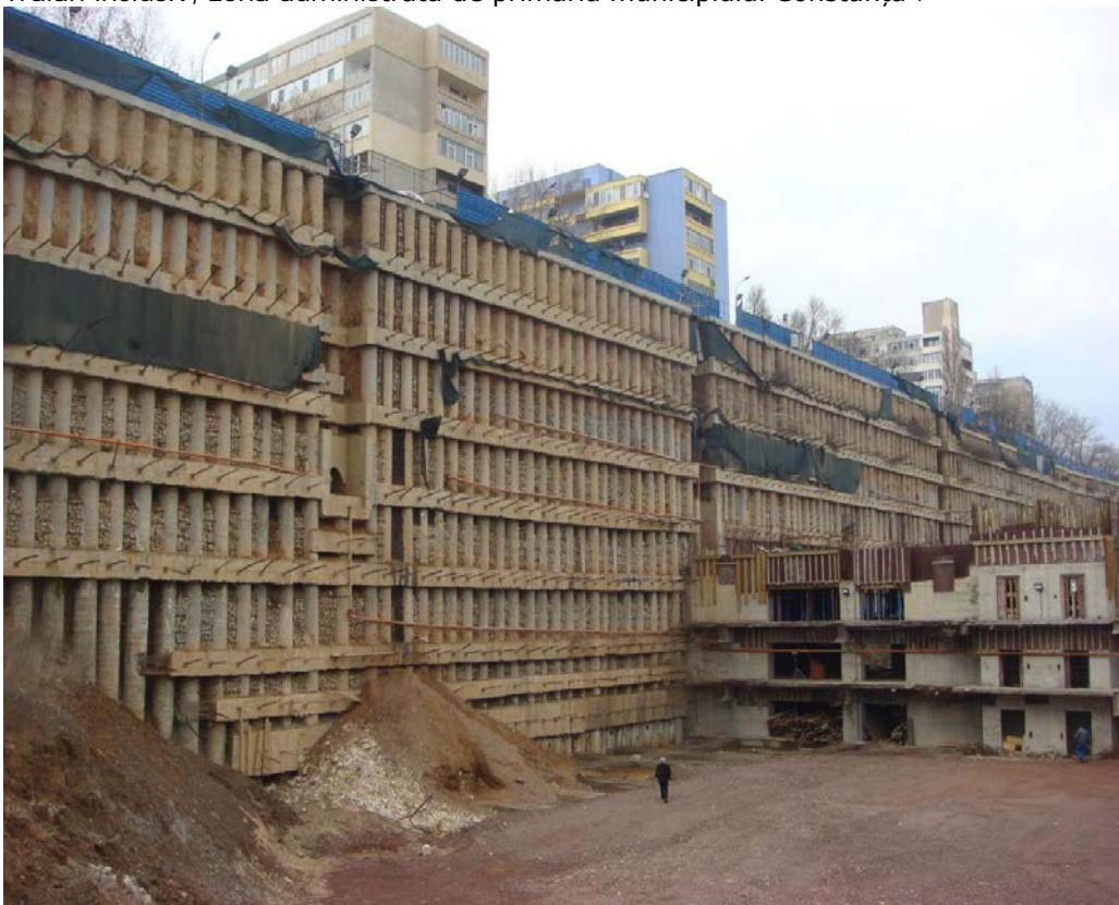
Fig. 5-1 Zona propusă spre studiul stabilității
