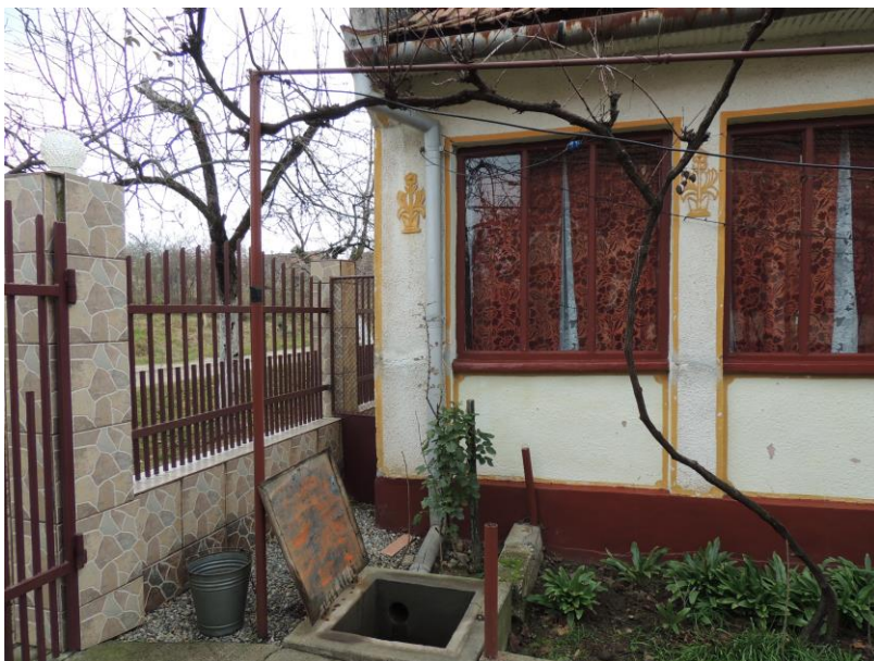
Fig. 2.36. Bazinul de colectare a apelor meteorice printr-un burlan de suprafață
