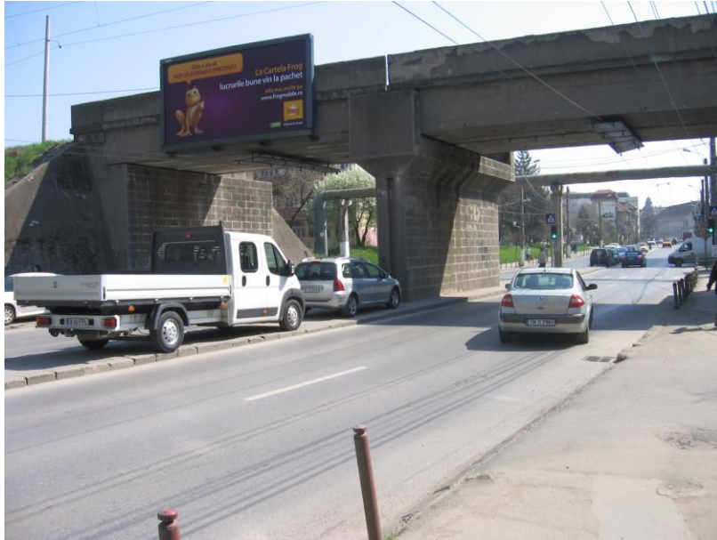
Fig.4.12. Viaductul Gheorghe Lazăr
