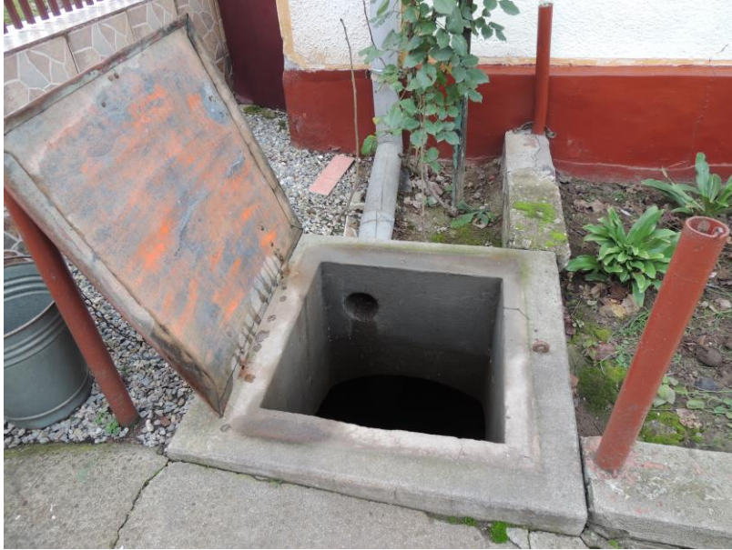
Fig. 2.38. Bazin colector subteran din beton armat
