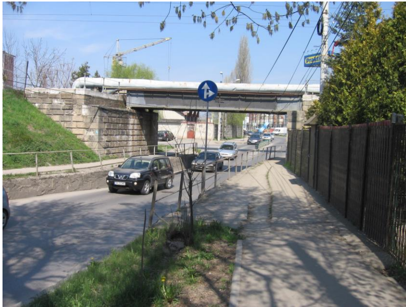
Fig.4.6 Viaductul Popa Șapcă
