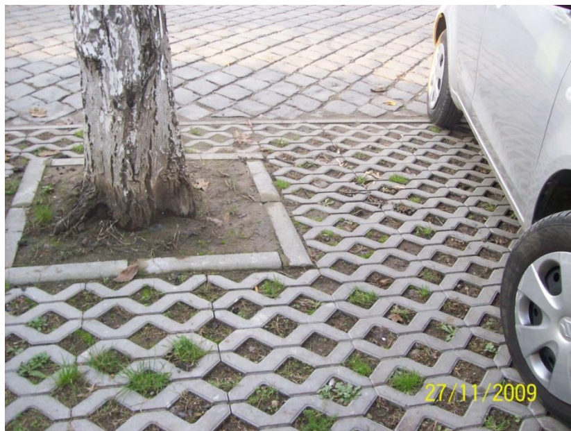
Fig.2.42. Pavaj cu rosturi înierbate.
