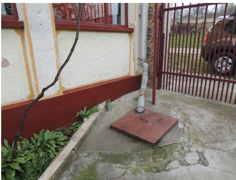
Fig. 2.37. Colectarea apelor meteorice prin jheaburi și burlane în bazine subterane
