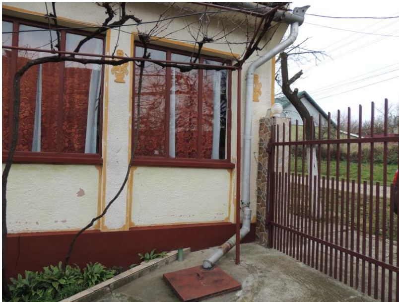
Fig. 2.35. Colectarea apelor meteorice prin jgheaburi și burlane de suprafață
