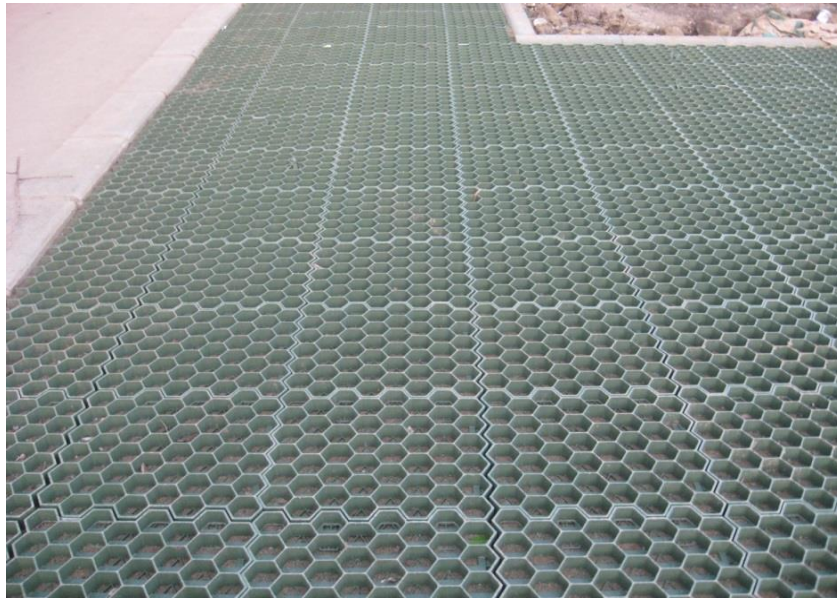
Fig.2.41. Grilaje pregătite pentru umplerea cu materiale granulare
