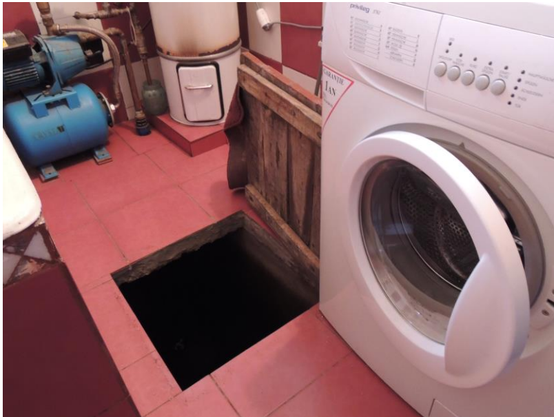
Fig. 2.39. Mașina de spălat rufe alimentată cu apă meteorică
