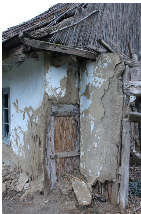
Fig. 6.3. și 6.4 Construcție tradițională C.A.Rosetti –Delta Dunării- păstrează sistemul structural neolitic în cadre de lemn, cu stâlpi încadrați în pământ. Sursă foto: A.M. Herpai, licența "Tabăra Pro-Vita, C.A.Rosetti
