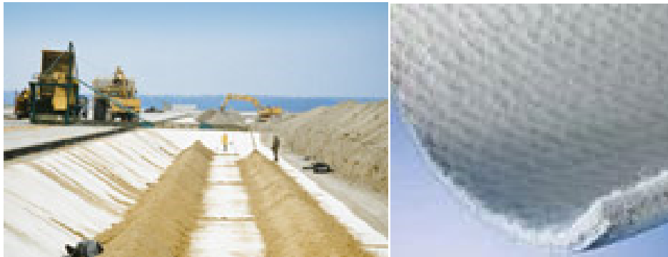
Fig. 2.28. Impermeabilizarea unui canal de colectare a apelor scurse de pe pista unui aeroport cu Bentofix, Naue
