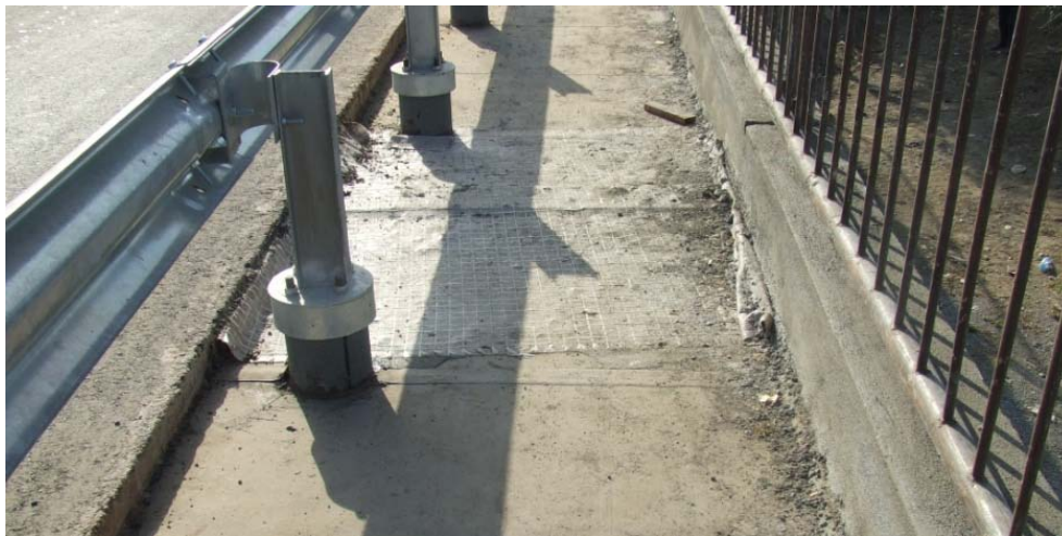
Fig.1.6. Montare rost cu soluție de geocompozit
