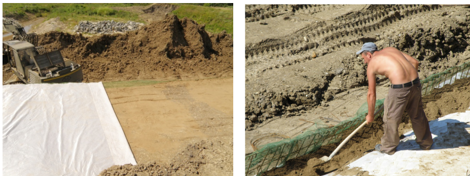
Fig. 5.20. Așternerea geocompozitului și realizarea unui strat pentru compactare
