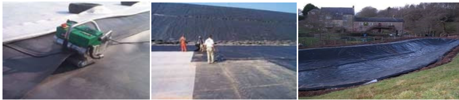
Fig. 2.34. Instalarea geomembranei pe taluz
