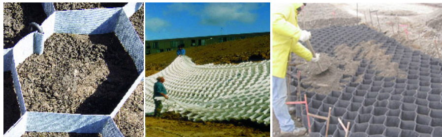
Fig. 2.30. Geocelulele tip Armater GL Geosintex, Eurocel Stefiprimex. Exemplu de punere în operă
