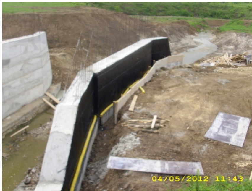
Fig. 5.4. Aripi monolite din beton armat
