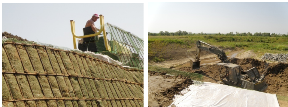
Fig. 5.21. Umplerea zonei exterioare cu pământ vegetal
