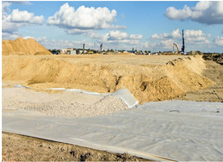
Fig. 2.11. Geotextil neșesut utilizat la separare de straturi
