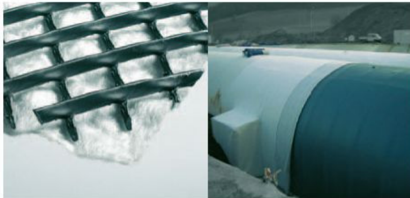
Fig. 2.24. Protejarea unei conducte (geocompozit tip Polyfelt DC)
