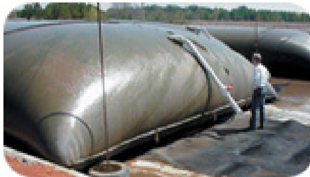
Fig. 2.32. Umplerea unui geotub Tencate cu deșeuri produse de o fabrică de hârtie.
