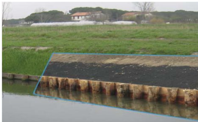
Fig. 2.18. Stabilizarea antierozivă pe malul unui canal de irigații efectuată cu georețea tip KMat L TeMa-Tegola
