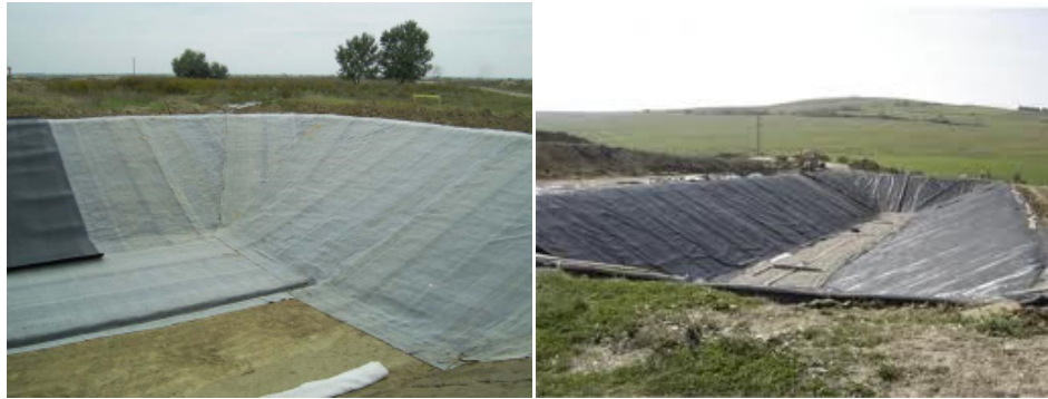
Fig. 2.26. Impermeabilizarea și încapsularea unui depozit de deșeuri realizat de Geocons
