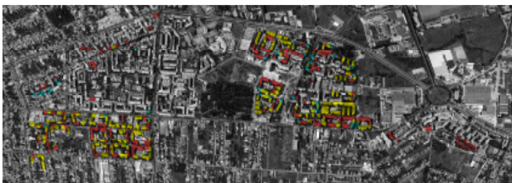
Fig.5.8. Tipologia T770 (Pa, Pb, Pc) în cartierele de blocuri din zona de sud a Timișoarei (Calea Girocului, Zona Soarelui)
