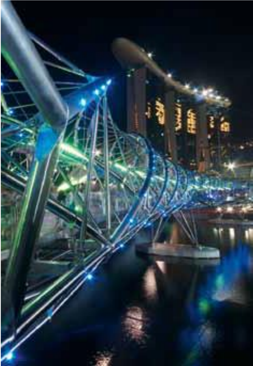
Fig.1.7 Executia unui pod din oțel inoxidabil Duplex [97]
