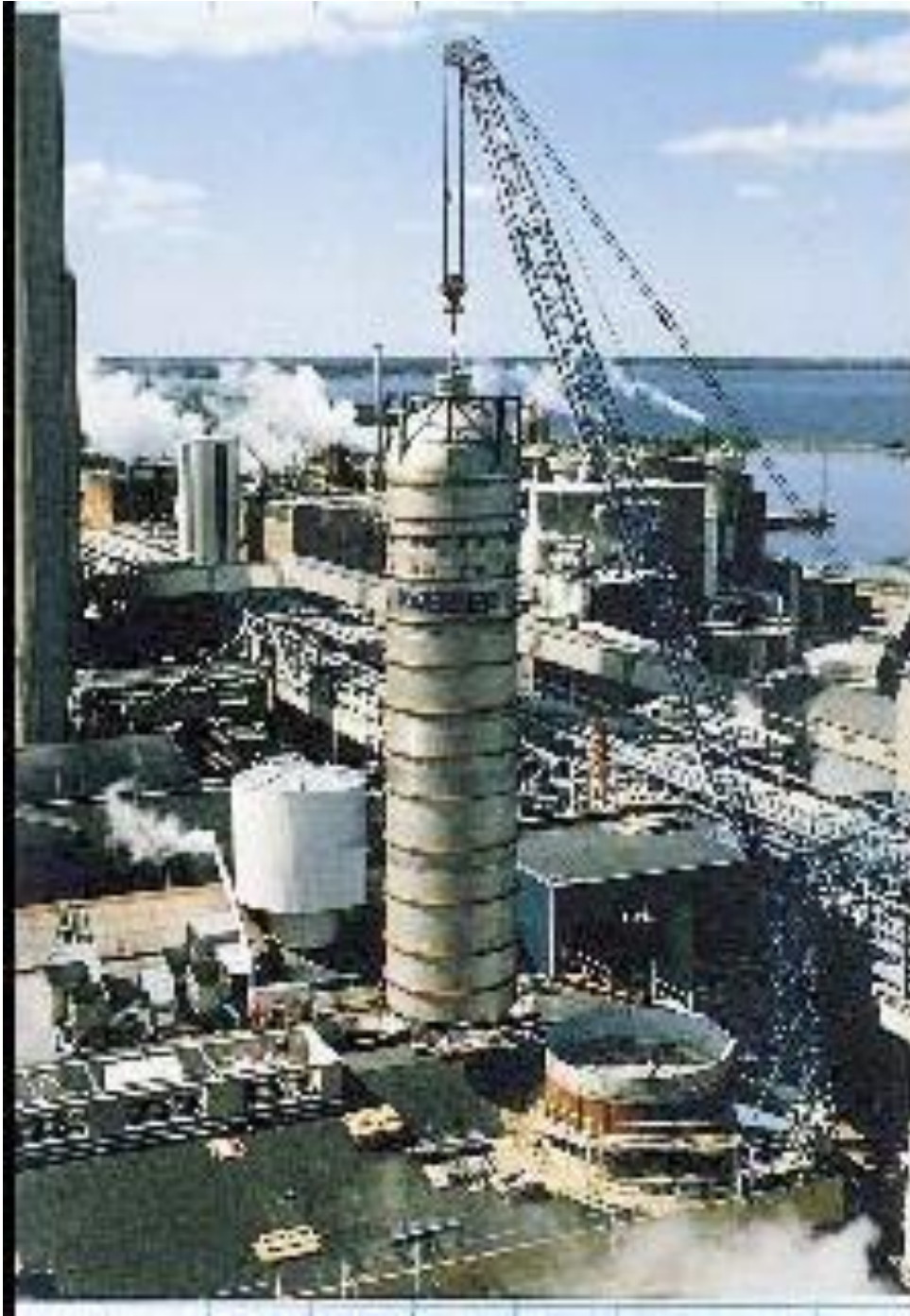
Fig.1.6 Reactor cu peroxid sub presiune, (Sursa: Avesta Polarit) [97]
