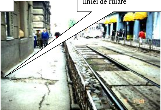
g), h), i) - Cale de rulare tramvai cu îmbrăcăminte din pavele.
