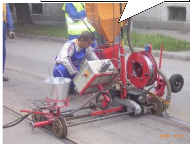
Fig. 1.64. Încărcarea prin sudură a șinei.
