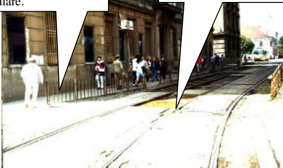
g), h), i) - Cale de rulare tramvai cu îmbrăcăminte din pavele.
