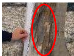
Fig. 4.80. Grupa III de deteriorare
