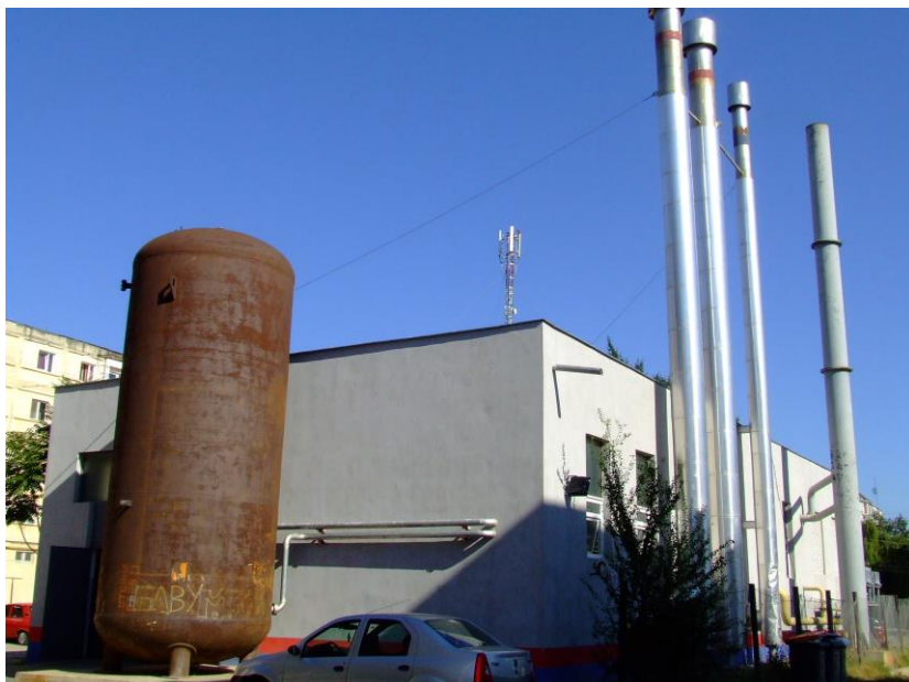
Figura 2.6. Vedere exterioară a CT Freidorf-Timișoara
