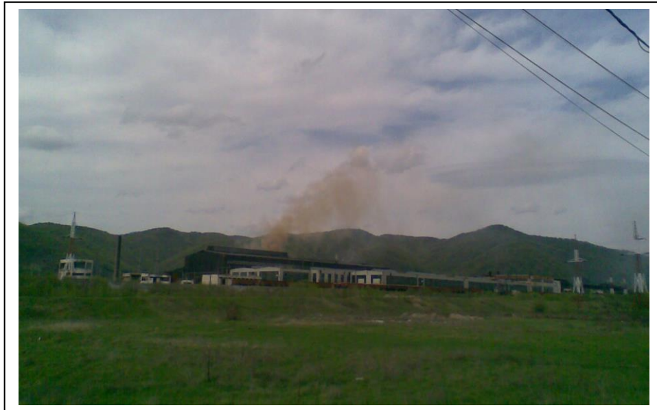
Fig. 4-3. Evacuarea necontrolată în aer a emisiilor de oxizi de fier în urma activității oțelăriei
