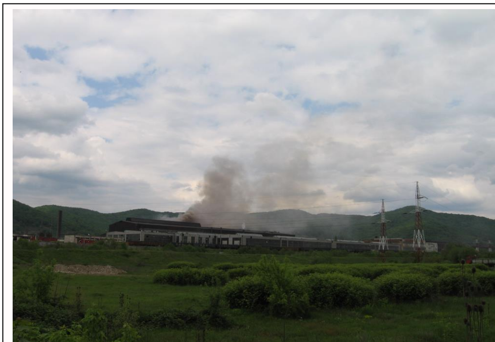
Fig. 2-34. Eliminarea „fumului cafeniu” la oțelăria din Oțelu Roșu
