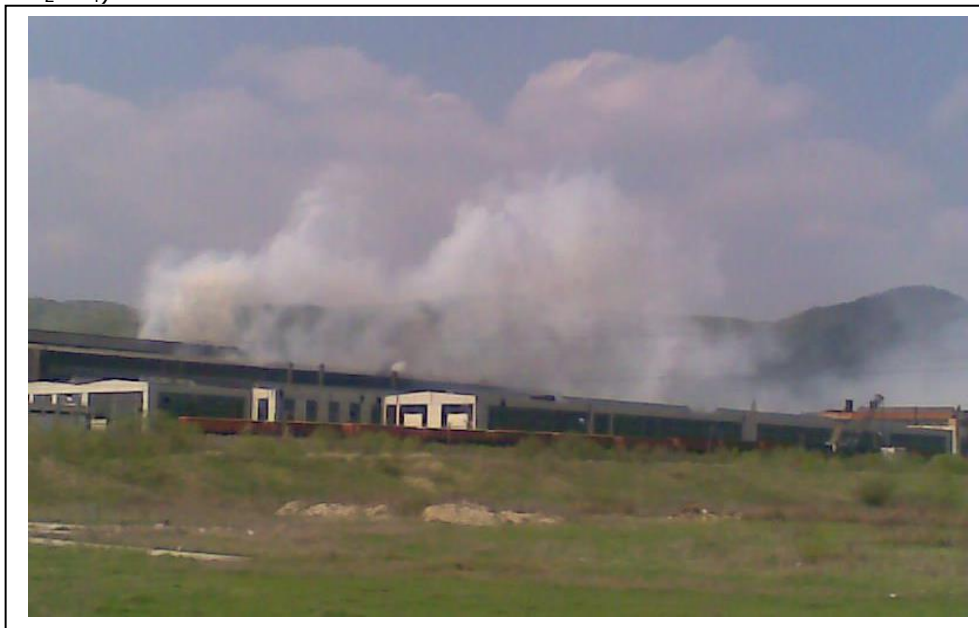
Fig. 4-2. Evacuarea necontrolată în aer a emisiilor rezultate din activitatea oțelăriei electrice
