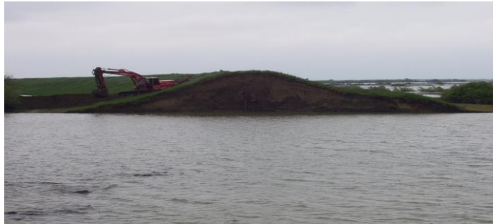
Fig.4.18. Cedarea digului și lucrările de îndiguire în zona de frontieră Foieni (2005)
