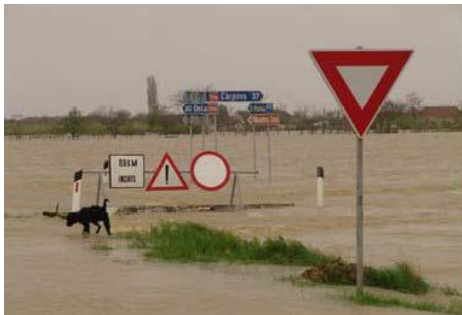
Fig. 5.34. Afectarea drumului Foeni
