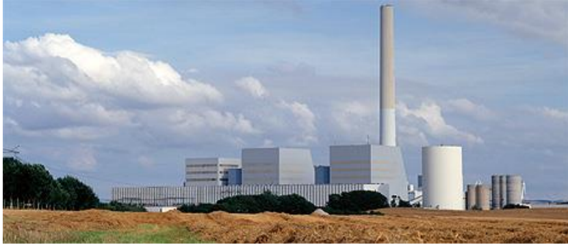
Fig. 3.14. Centrala electrică Studstrup din Danemarca [94]
