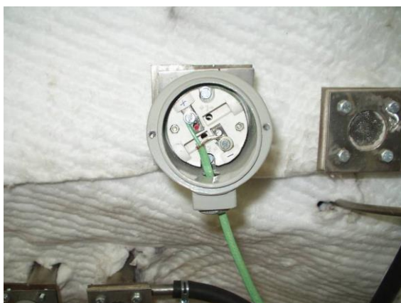
Fig. 4.39. Conexiune termocuplu tip K
