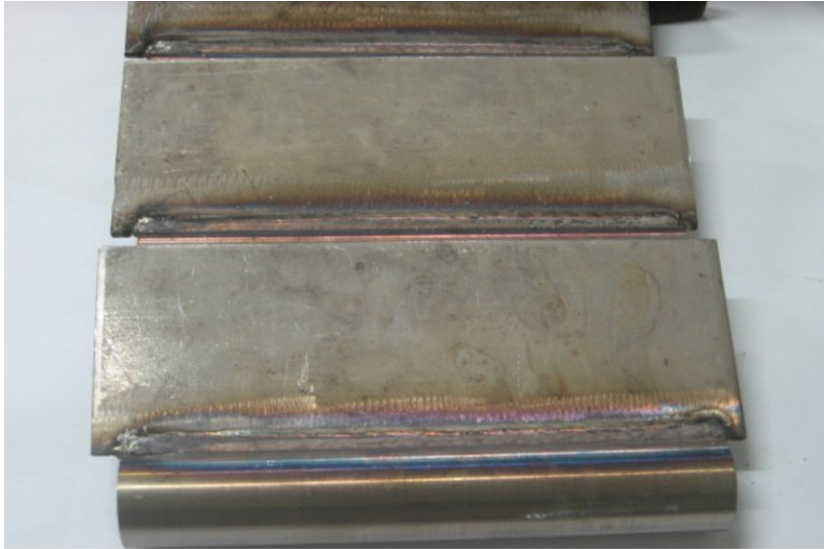
Fig. 5.7. Aspectul exterior al suprafeței sudurilor – Fața I
