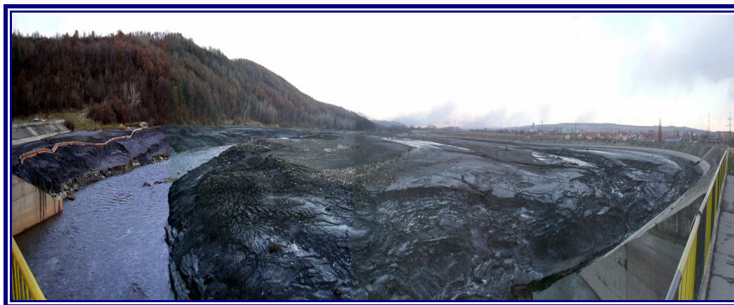
Fig.3.12 Acumularea Vădeni Colmatarea prematură a chiunetei cu suspensii de carbune
